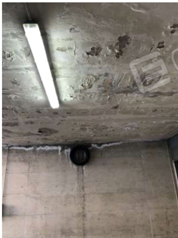
Foto 18: particolare infiltrazioni)
