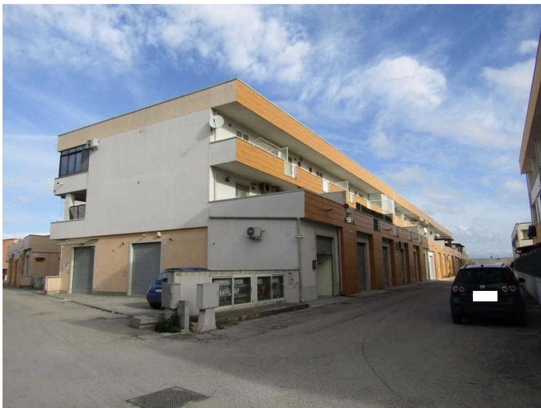
FOTO 10.1 - LOTTO 10 – BOX AUTO IN FOGGIA – FABBRICATO B
