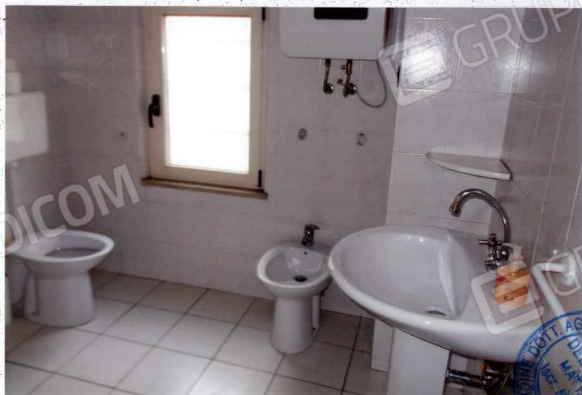
FOTO N. 8 – PARTICOLARE LOCALE BAGNO
