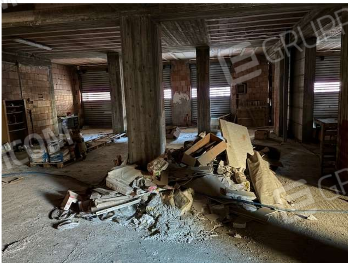
Foto n. 4 – Interno del sub 195 allo stato rustico (a destra della scala B)
