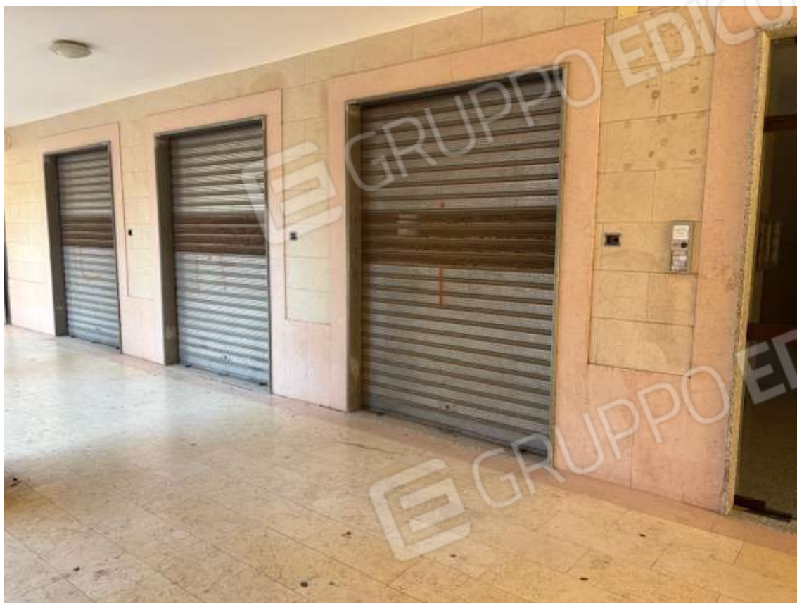
Foto n. 1 – Ingresso ai terranei subb 175 e 195 (a destra della scala B)
