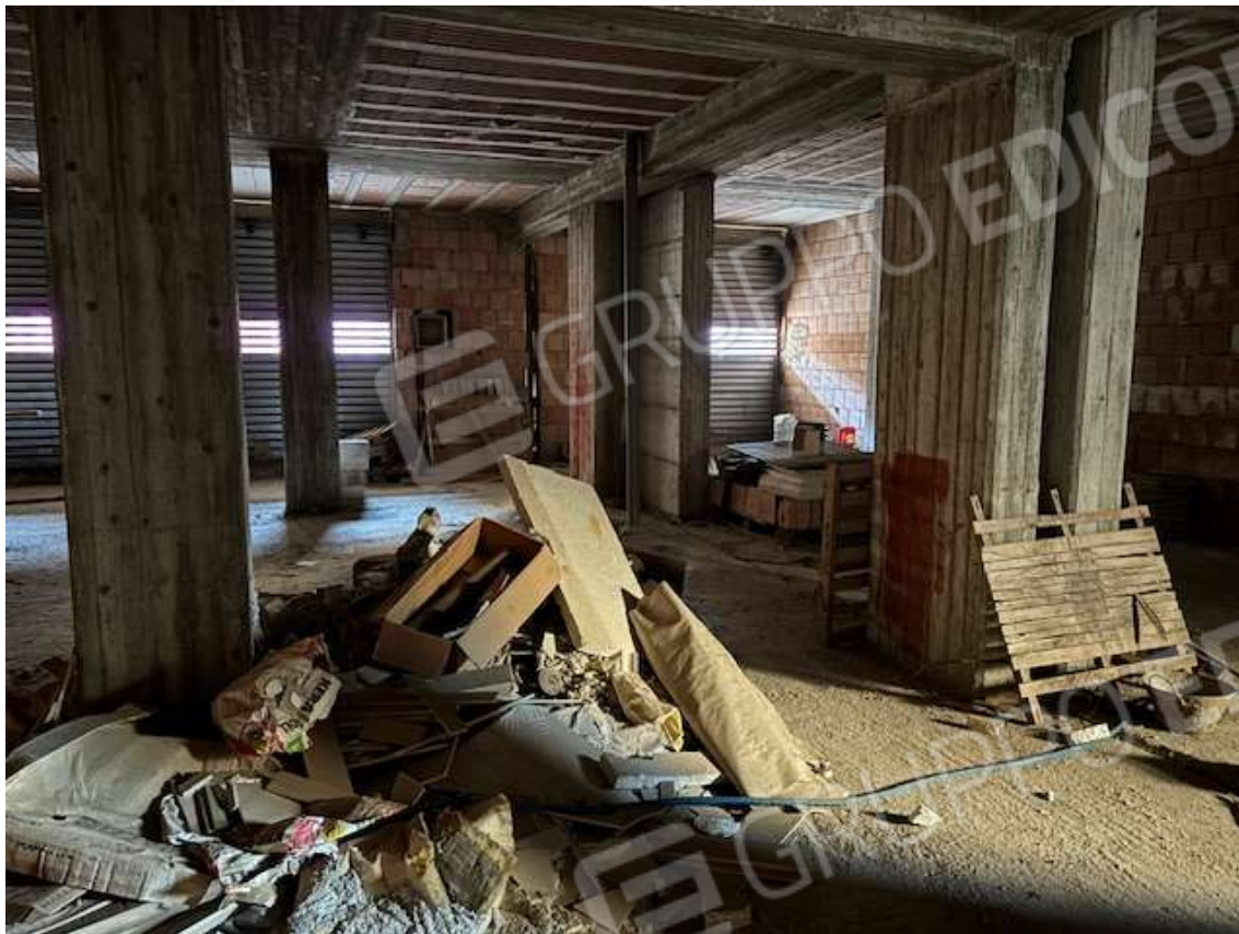
Foto n. 5 – Interni del sub 195 e del sub 175 allo stato rustico
