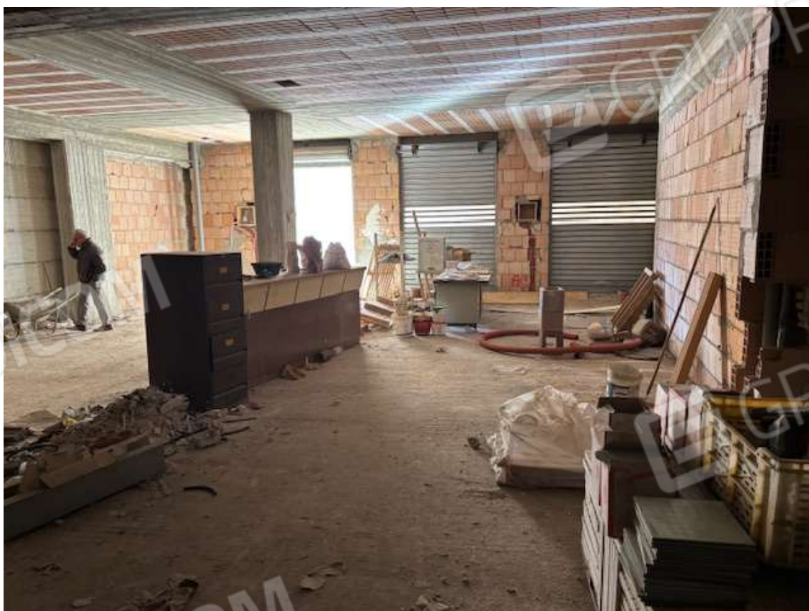
Foto n. 8 – Sub 195 (a sinistra della scala B)
