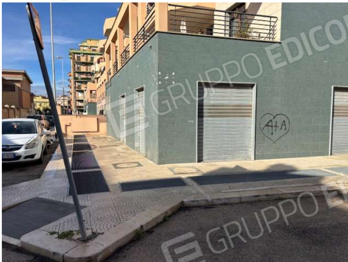
Foto n. 15 – Prospetto esterno del terraneo, angolo via Trento e via G. La Pira
