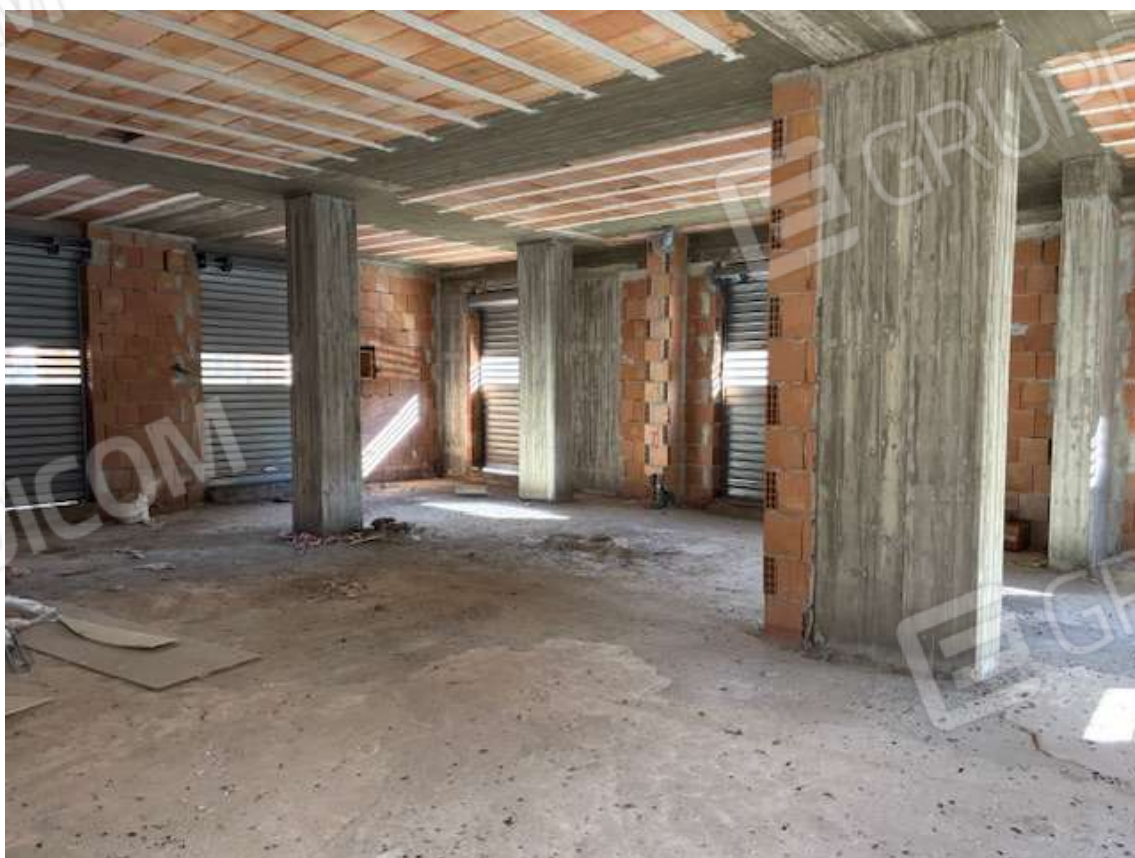
Foto n. 12 – Interni del terraneo con vista degli ingressi verso spazio condominiale interno e via Trento
