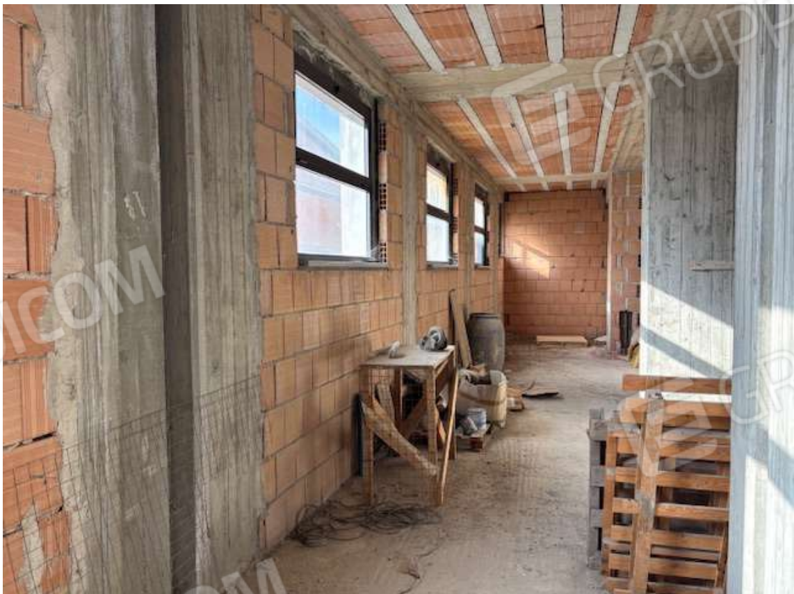
Foto n. 8 – Interni del terraneo, parete di confine con Via G. La Pira e altro sub.
