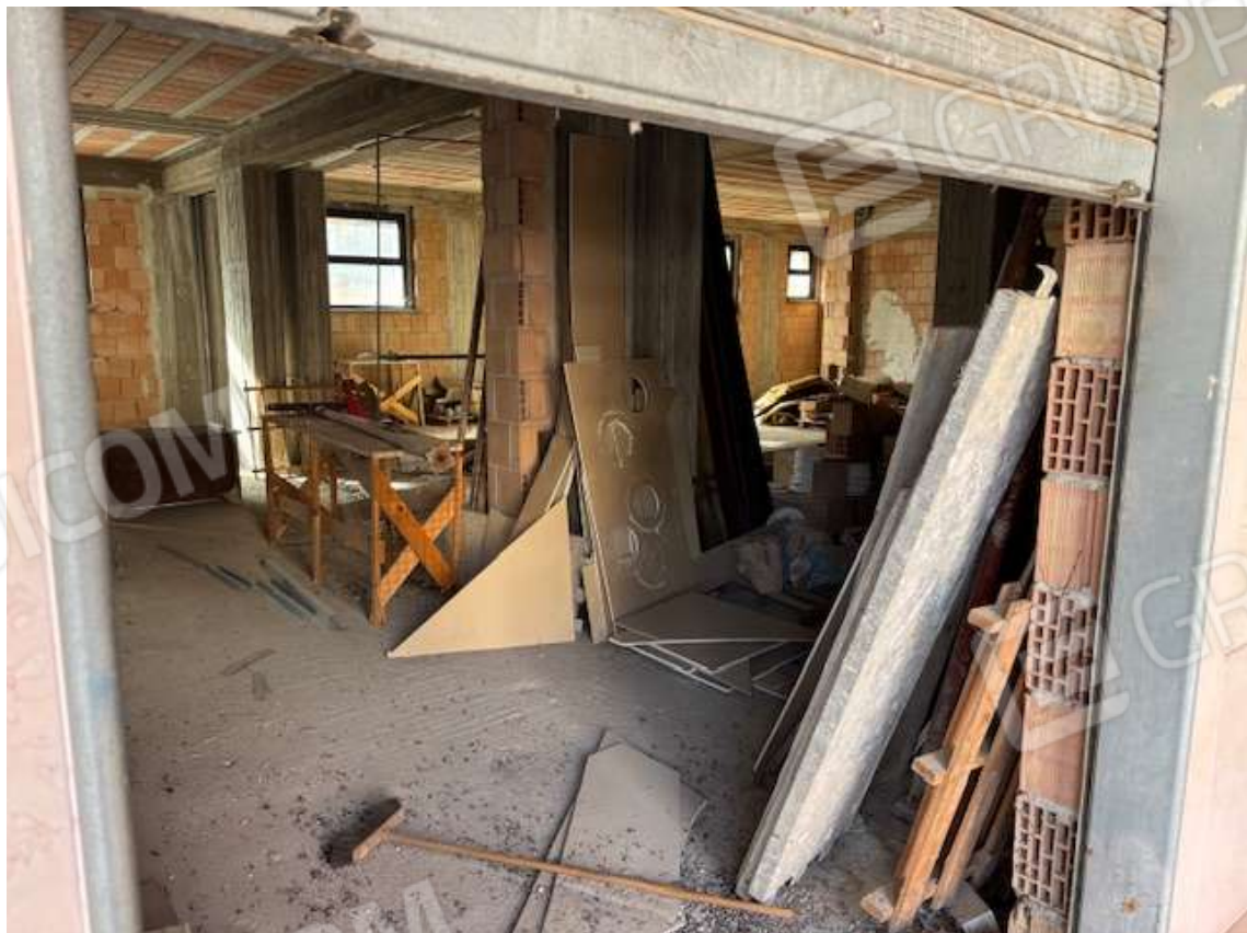
Foto n. 4 – Ingresso e interni al terraneo sub 189
