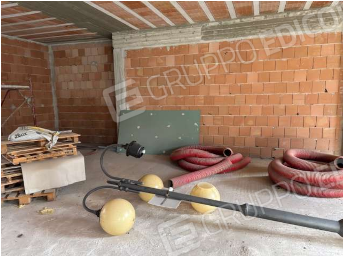
Foto n. 7 – Interni del terraneo e parete di confine con la scala D e altro sub.
