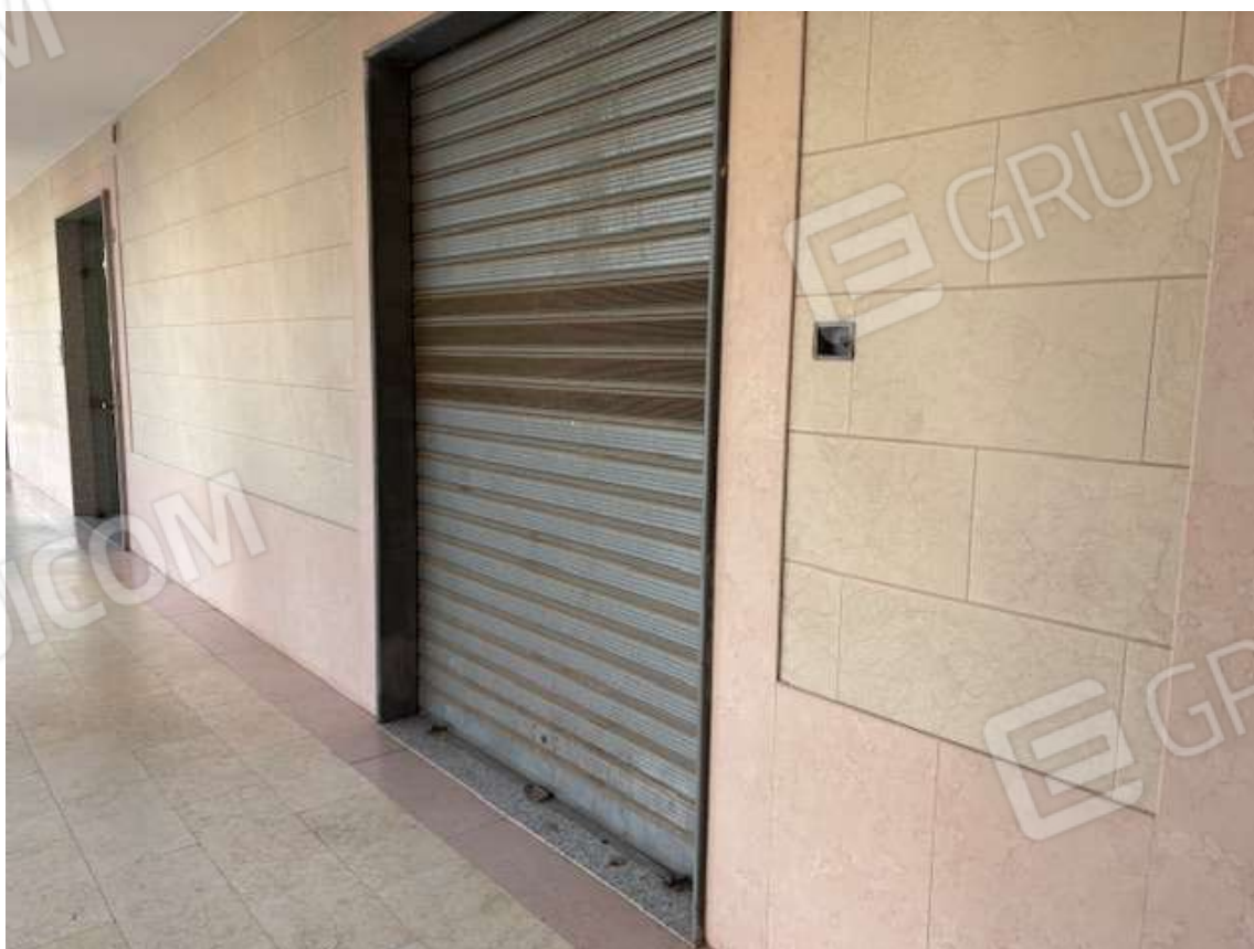
Foto n. 2 – Ingresso al terraneo sub189 (a sinistra della scala G)
