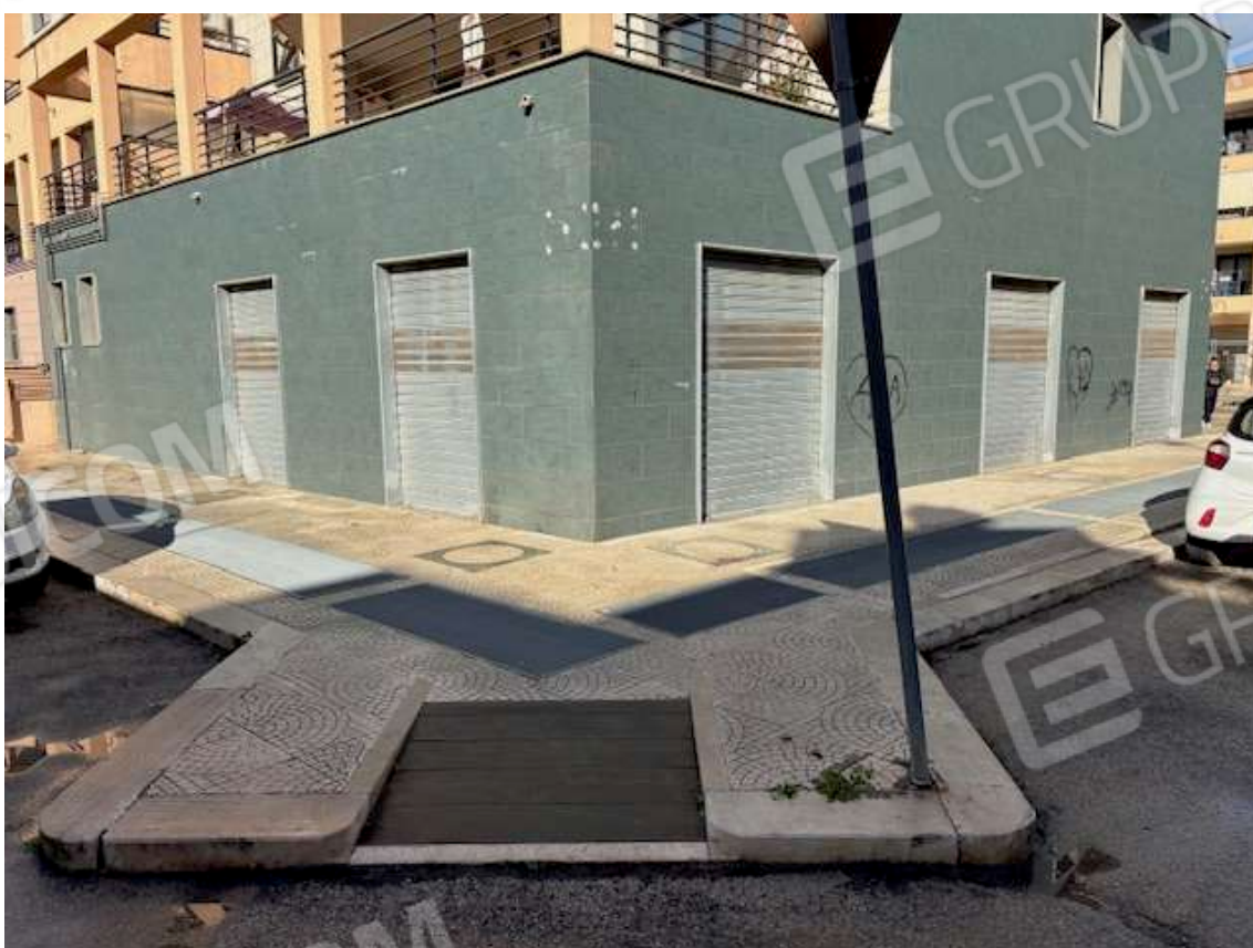
Foto n. 16 – Prospetto esterno del terraneo, angolo via Trento e via G. La Pira
