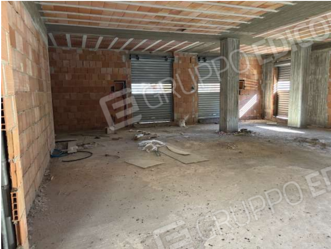
Foto n. 11 – Interni del terraneo con parete di confine scala G, vista degli ingressi verso spazio condominiale interno e via Trento
