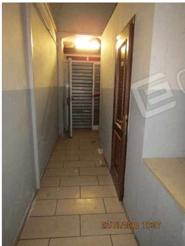
FOTO N. 33 – Locali commerciali al piano terra, particolare interno.
