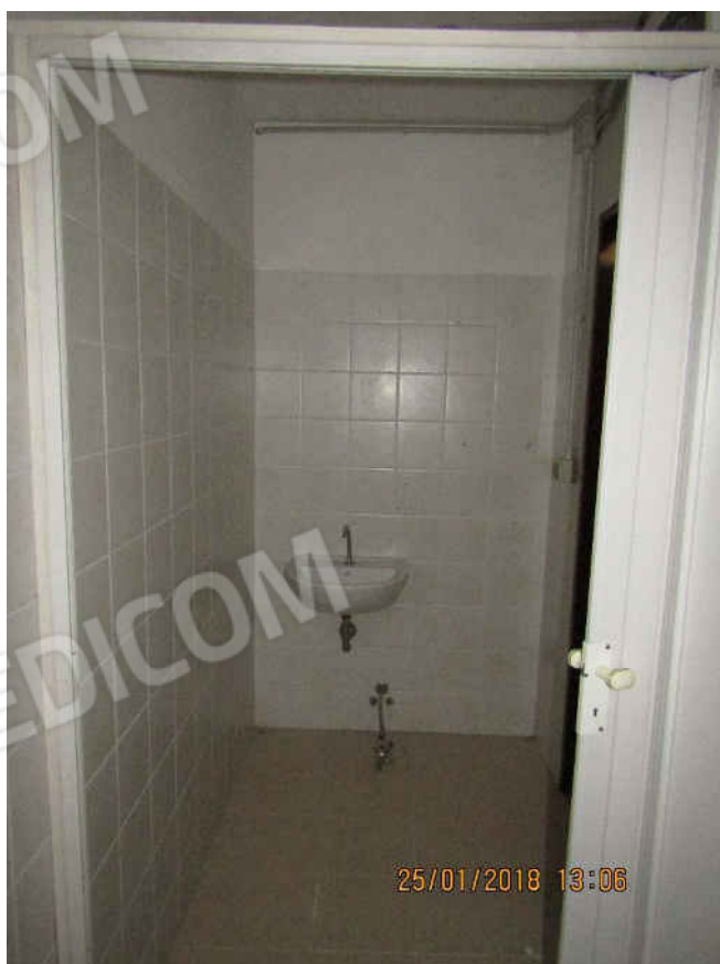
FOTO N. 34 – Locali commerciali al piano terra, particolare interno.
