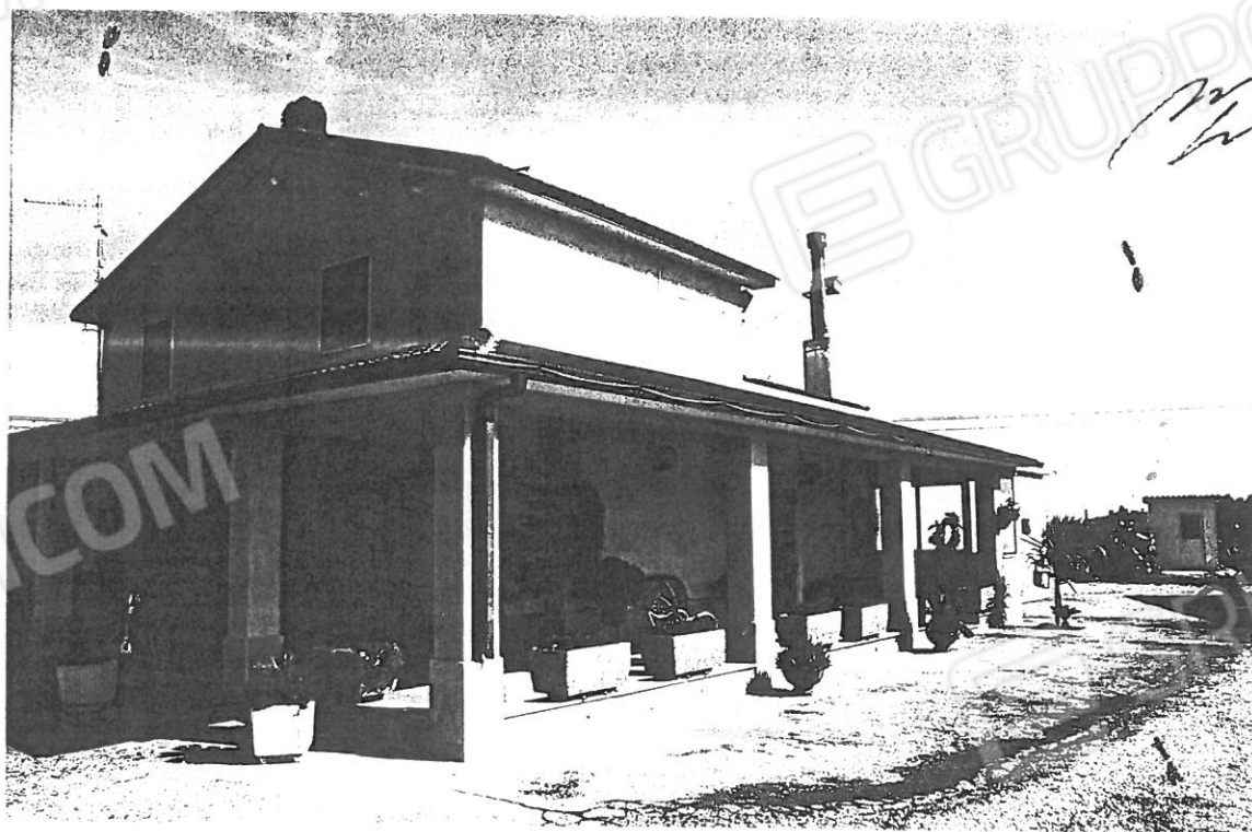
2 Il fabbricato rurale con il portico su due lati al pianterreno ed il primo piano
