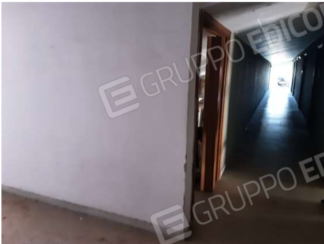
Foto 23 – sopralluogo del 30 marzo '21
