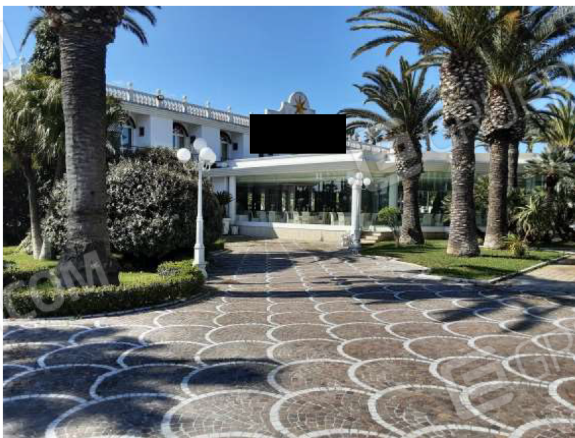
Foto 8 – sopralluogo del 6 aprile '21
