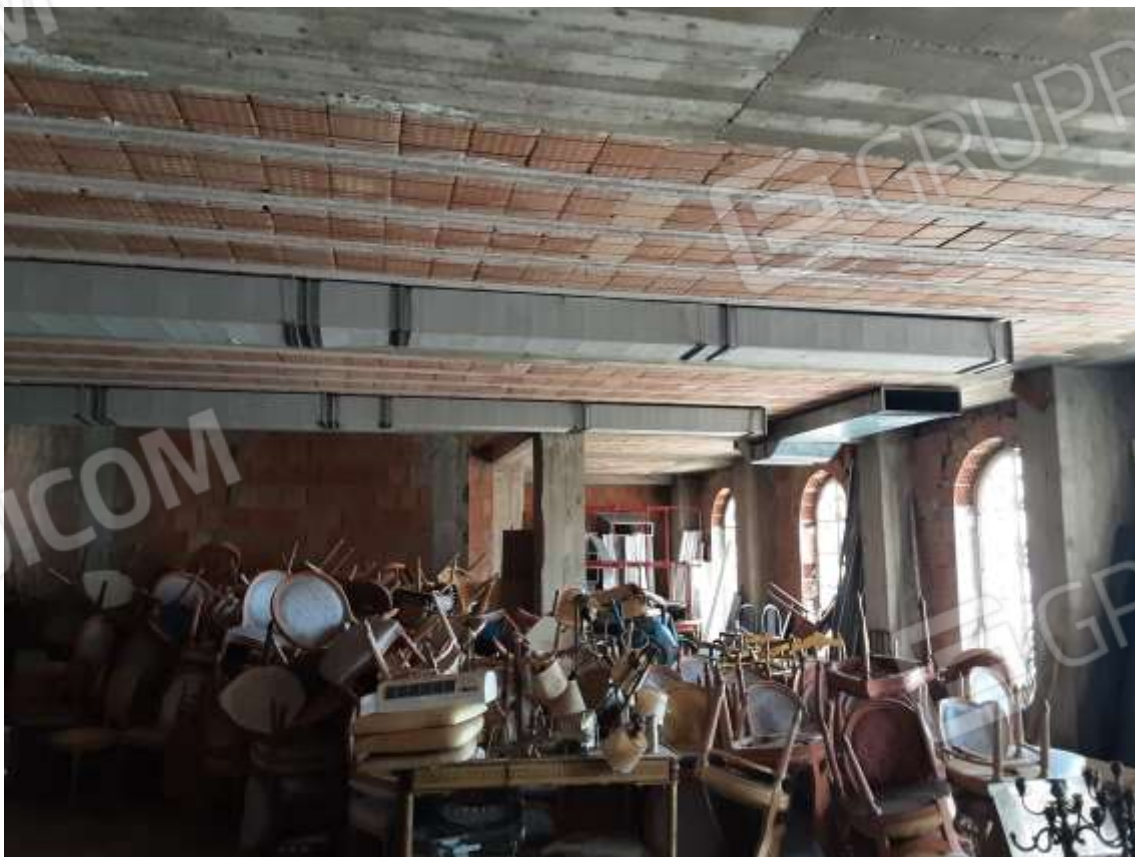
Foto 22 – sopralluogo del 30 marzo '21
