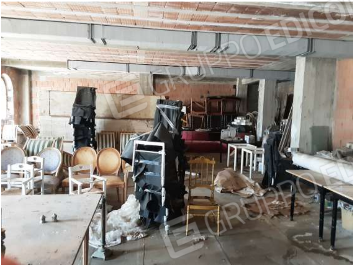
Foto 21 – sopralluogo del 30 marzo '21
