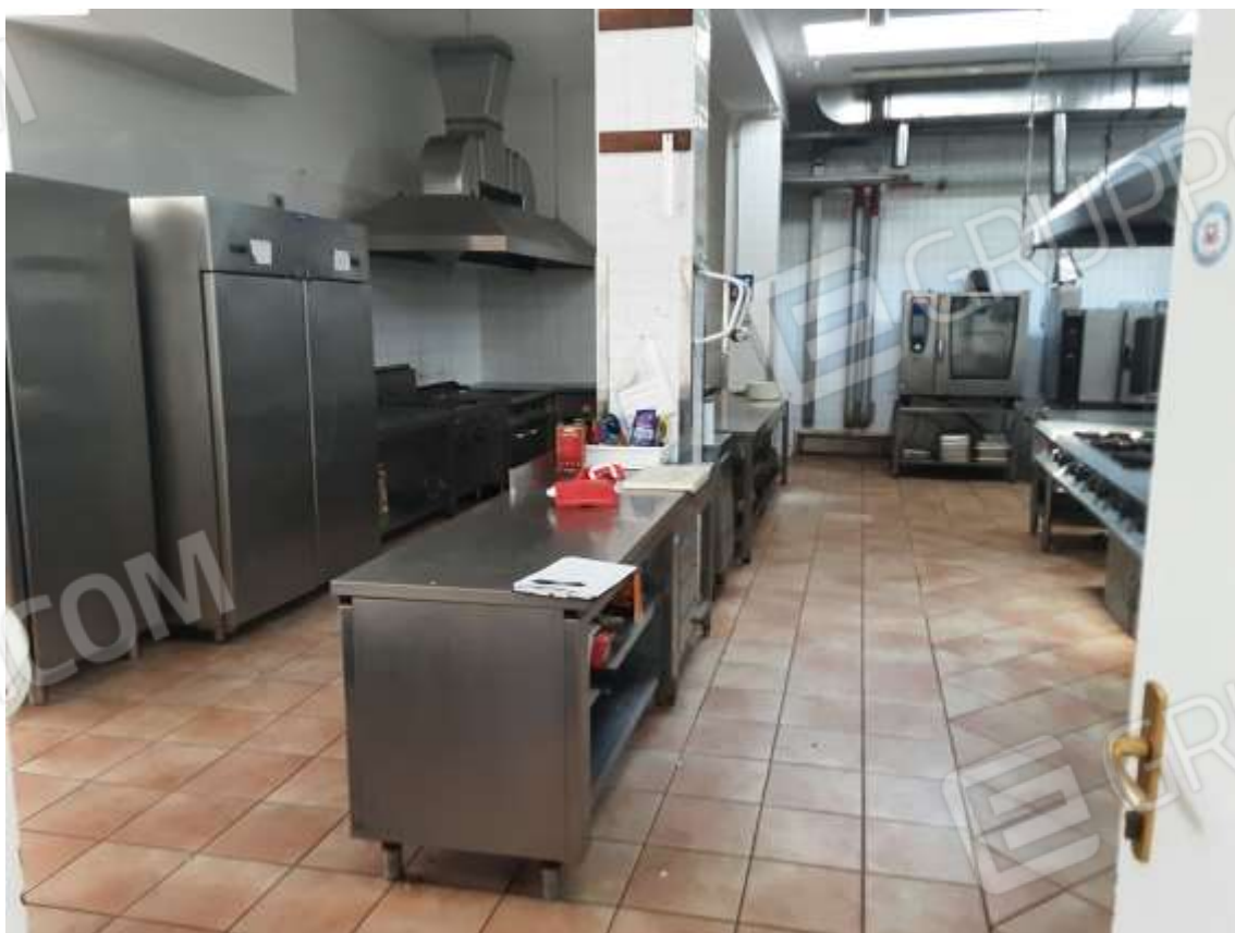
Foto 6 – sopralluogo del 30 marzo '21
