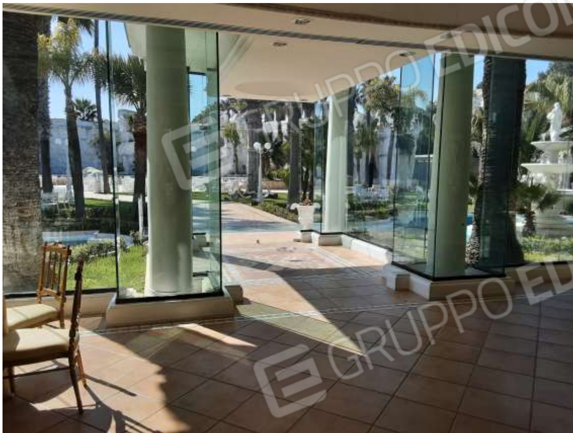
Foto 5 – sopralluogo del 30 marzo '21
