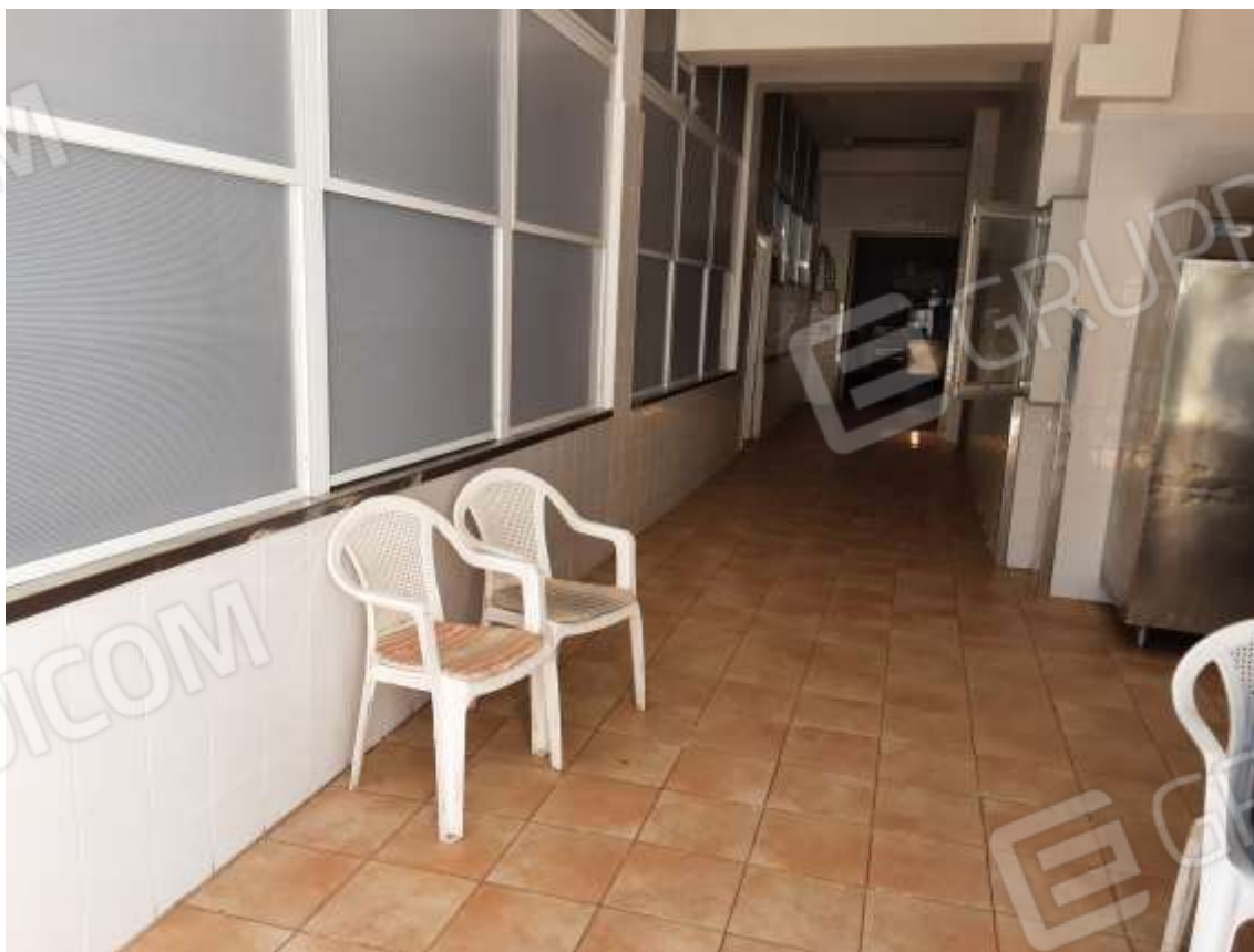
Foto 8 – sopralluogo del 30 marzo '21
