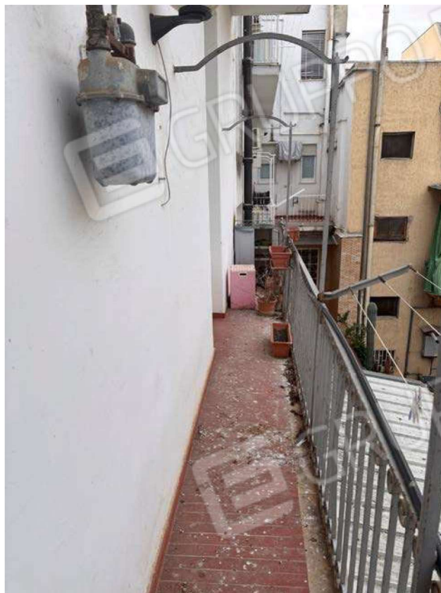
Foto 21: Balcone lato interno (cortile)
