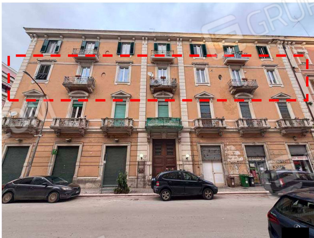
Foto 2: vista completa stabile condominiale
