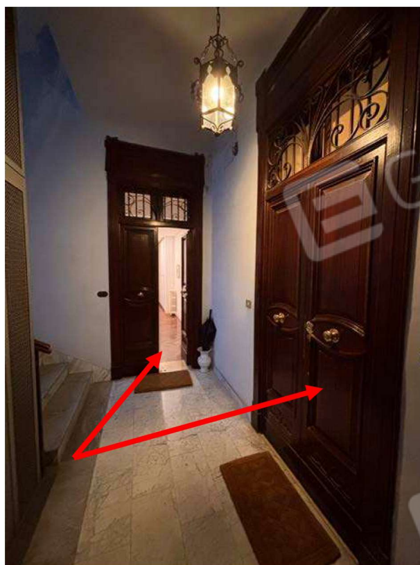
Foto 4:n. 2 porte di caposcala in Piano 2°
