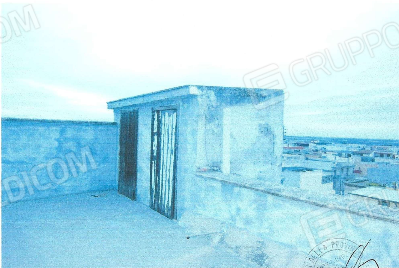
10 – Part. ripostiglio livello terrazzo comune fabbricato
