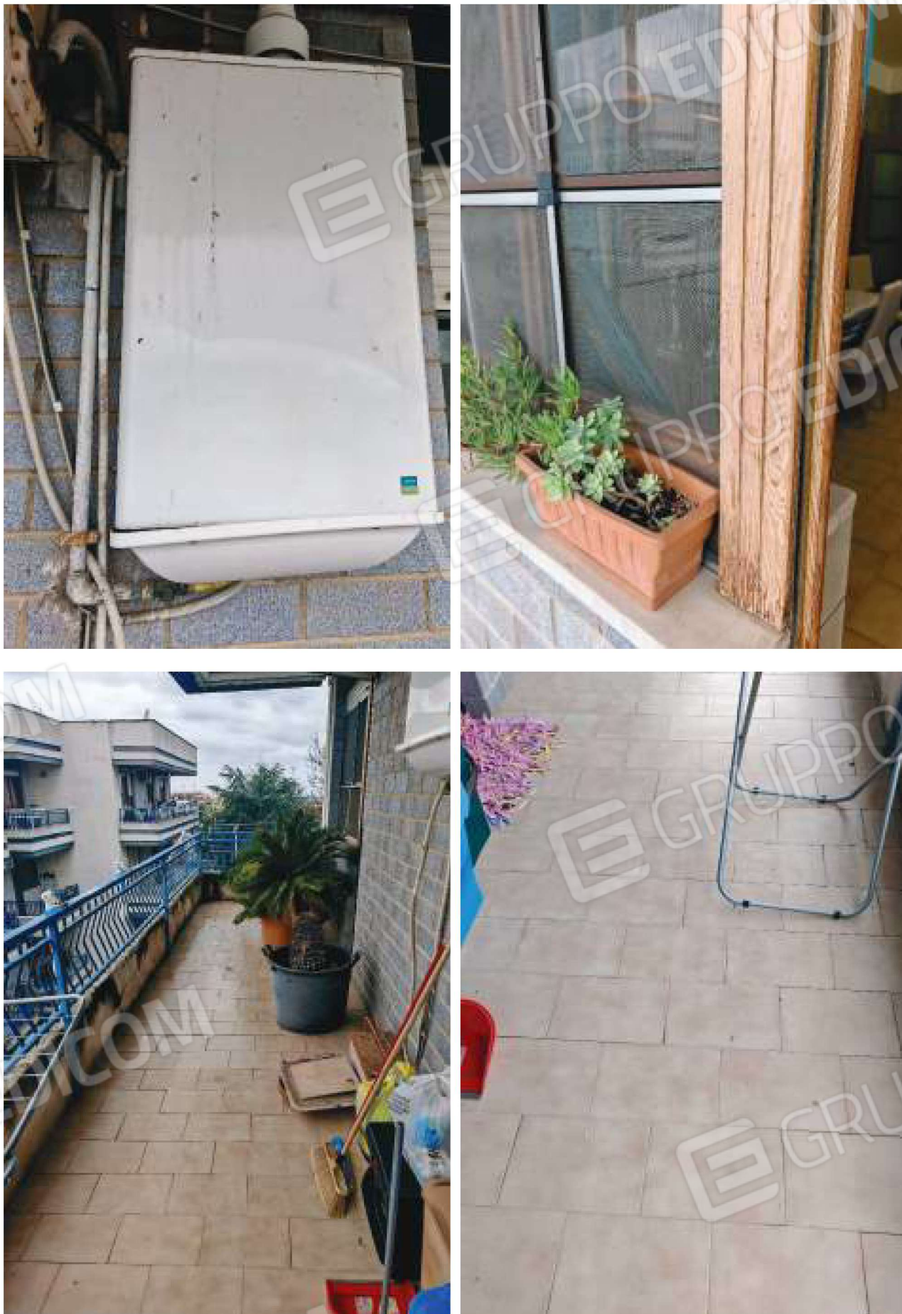
Figura 12: interno appartamento (balcone)
