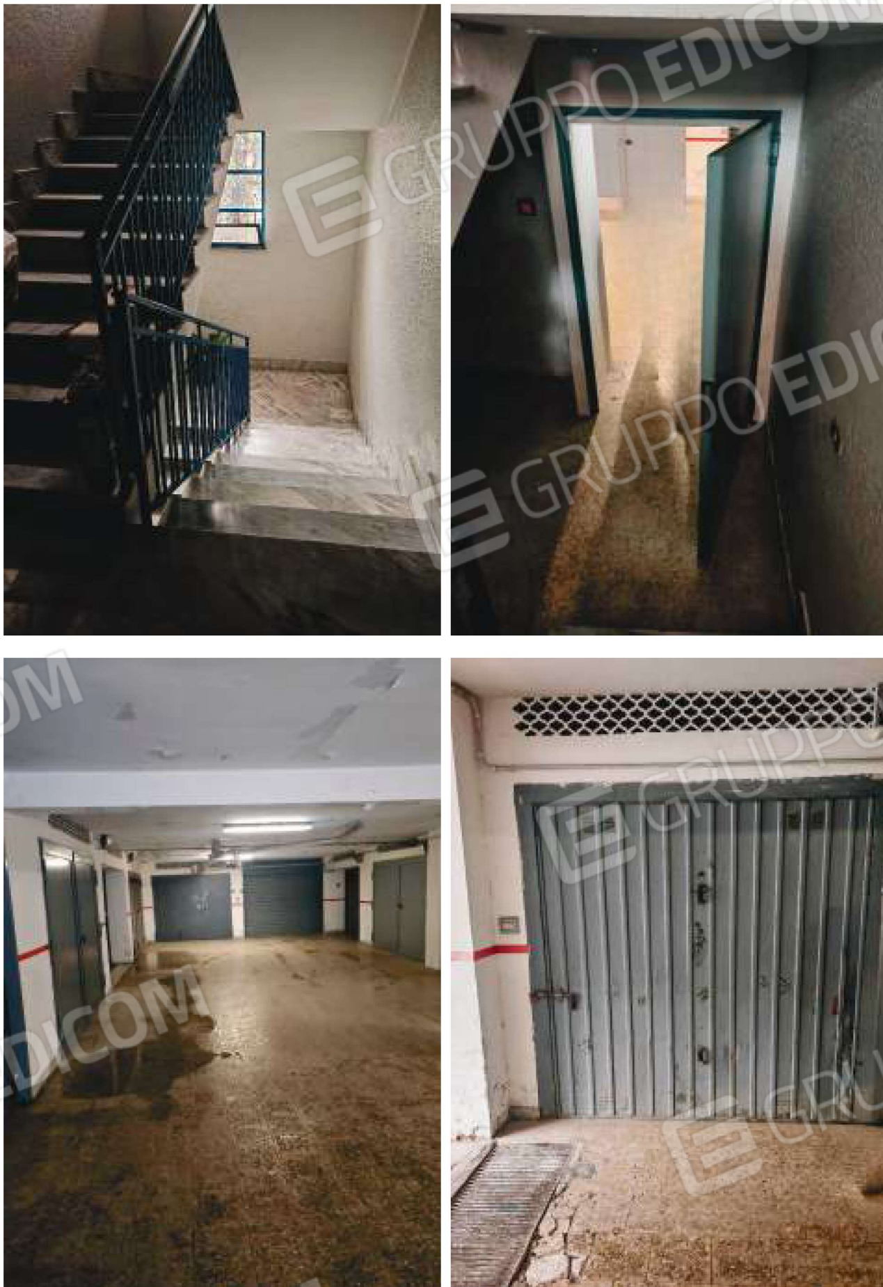
Figura 17: scala condominiale di accesso al piano S1
