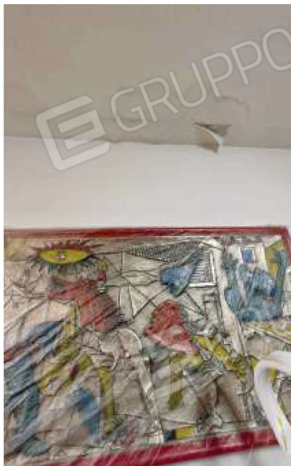
Figura 8: interno unità immobiliare (particolare infiltrazione proveniente dal lastrico solare)
