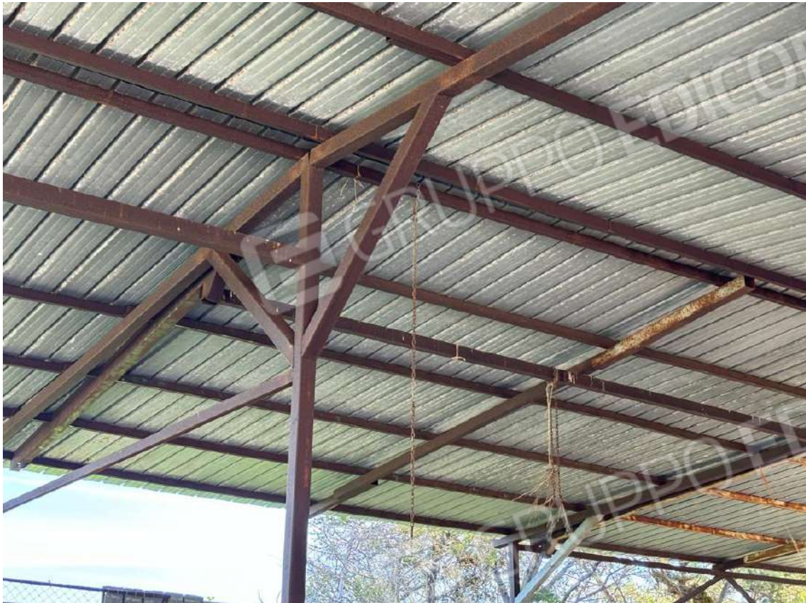
Foto n. 21 – Particolari strutturali del fabbricato fgl 22, p.la 138 sub 1
