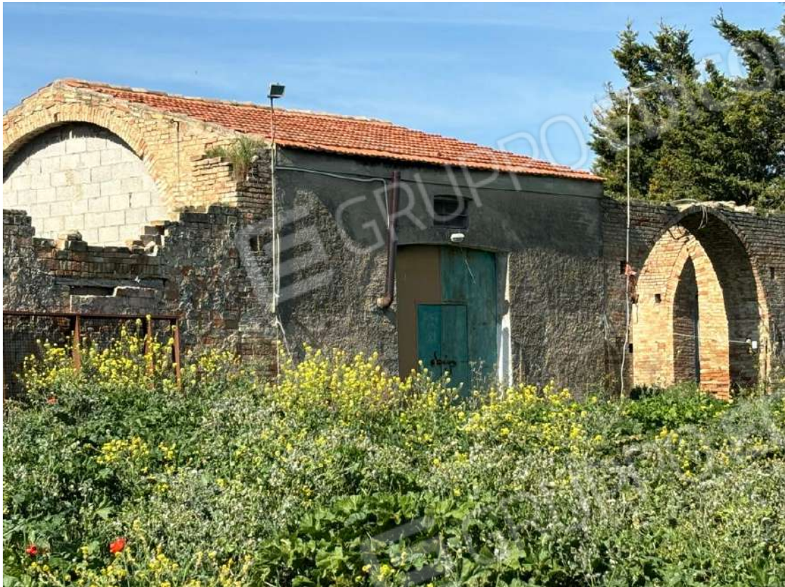
Foto n. 13 – Foglio 22, p.lla 144 (ex 116) – deposito
