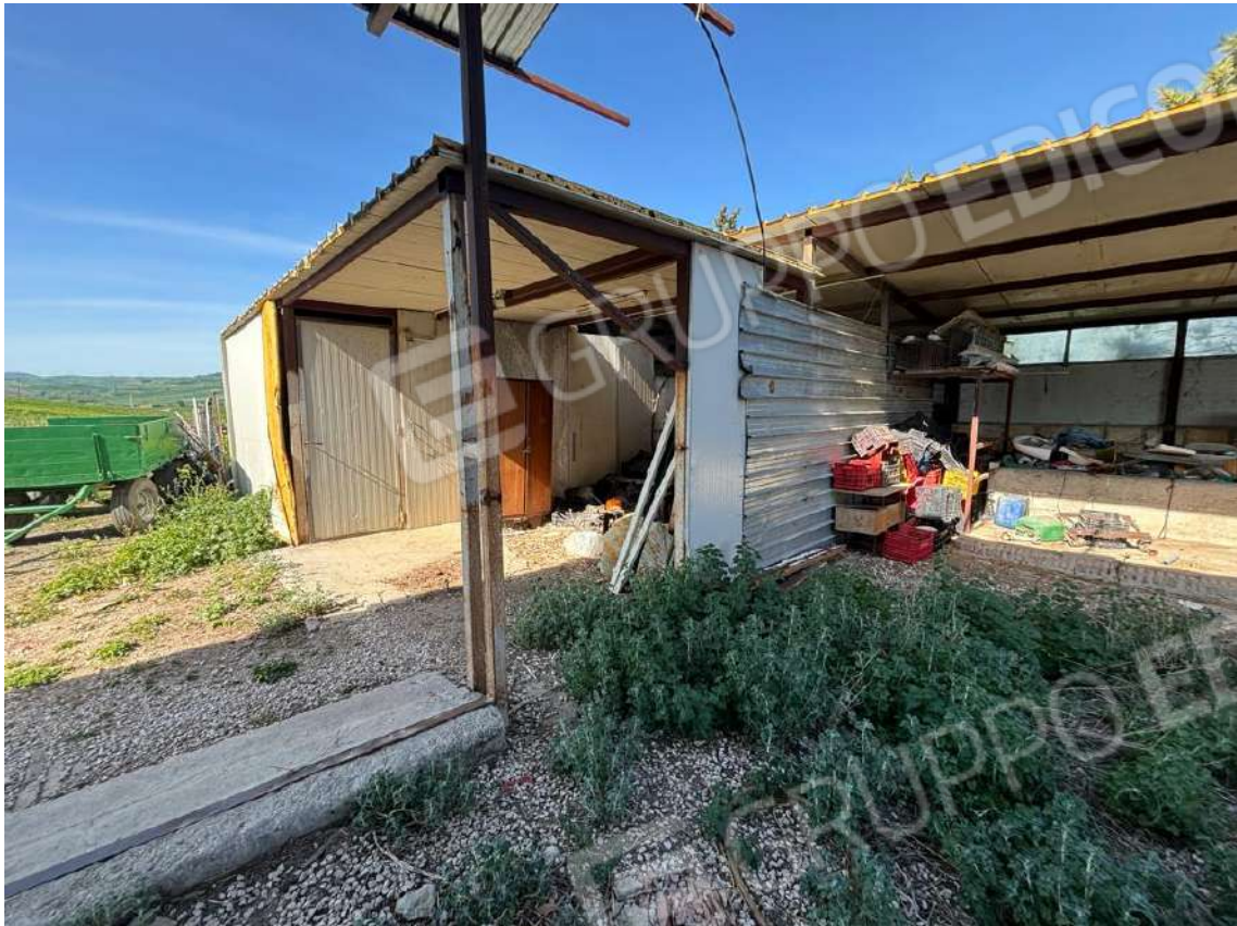
Foto n. 17 – Particolari del fabbricato fgl 22, p.lla 138 sub 1
