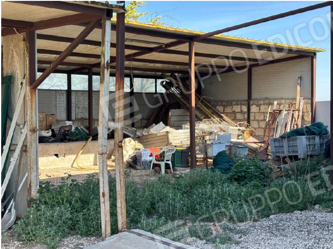
Foto n. 23 – Particolari strutturali del fabbricato fgl 22, p.lla 138 sub 1
