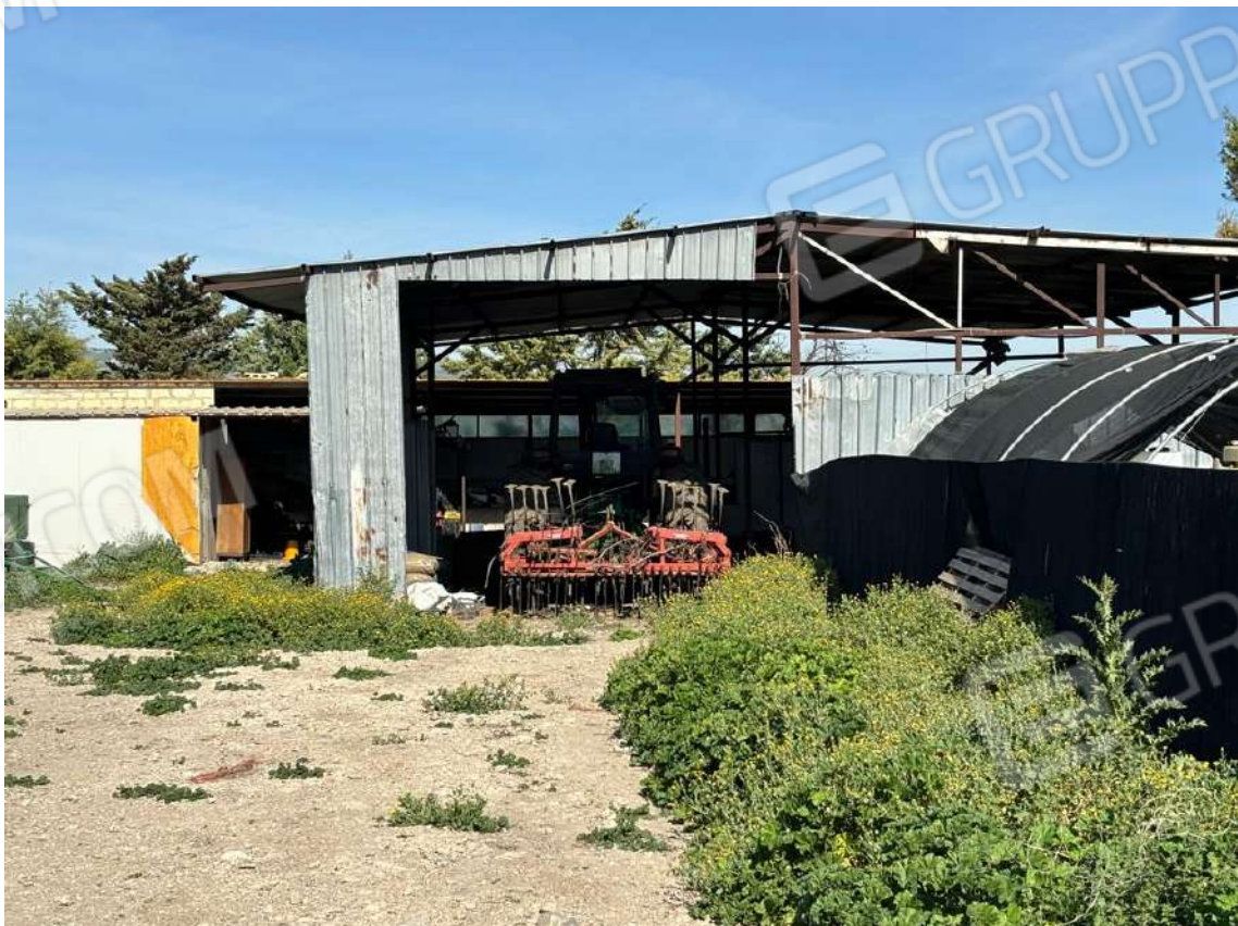
Foto n. 24 – Prospetto del fabbricato fgl 22, p.lla 138 sub 1
