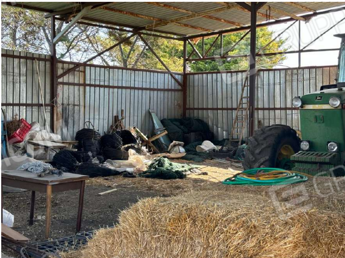
Foto n. 22 – Particolari strutturali del fabbricato fgl 22, p.la 138 sub 1
