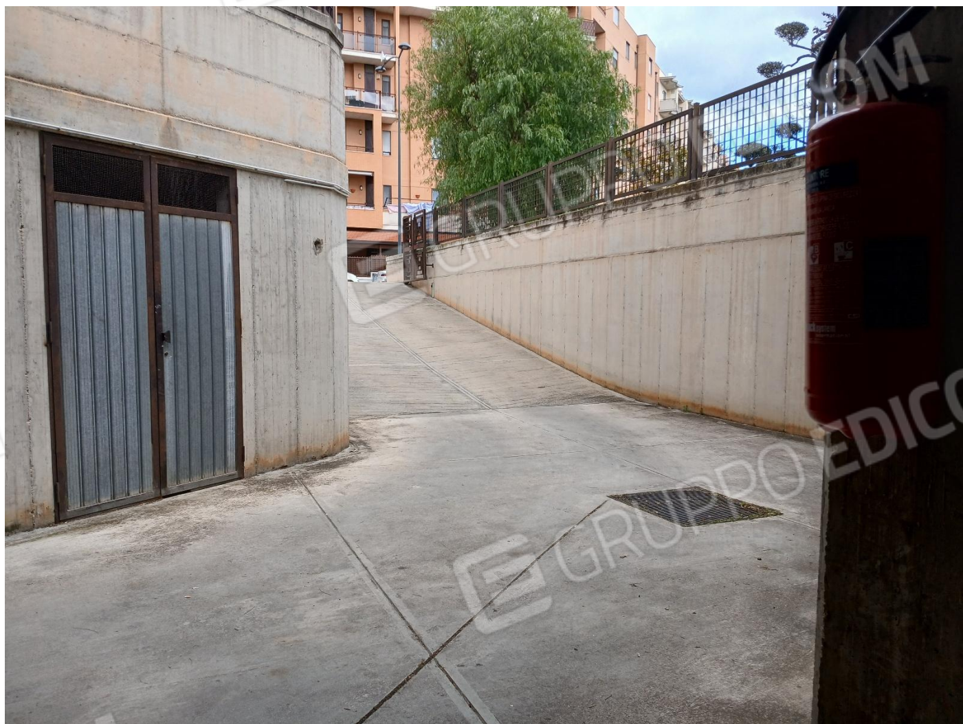
RAMPA DI ACCESSO AL BOX AUTO
