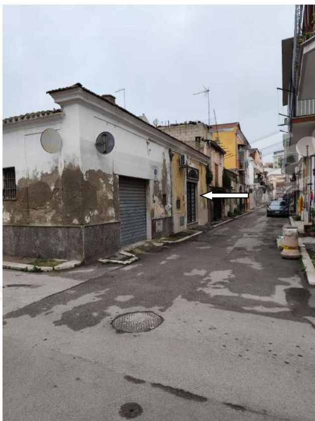
FOTO N. 1 – VISTA PROSPETTICA DI VIA DELL'UVA
