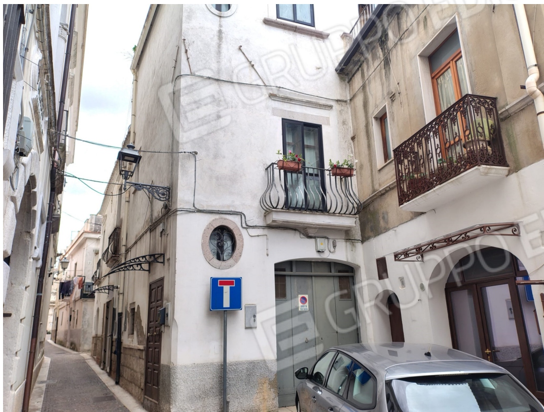
Facciata dell'appartamento oggetto di causa
