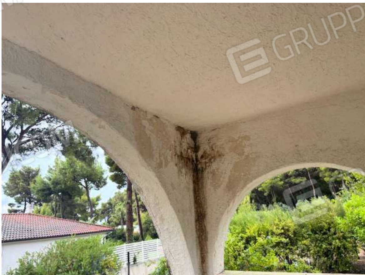
Foto n. 18 – Particolare del portico coperto antistante il fabbricato
