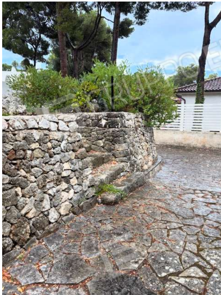
Foto n. 7 – Viabilità veicolare e pedonale limitrofa al fabbricato
