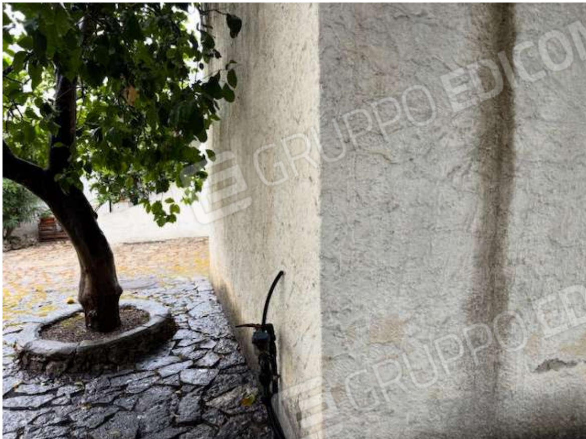
Foto n. 11 – Particolare delle pareti perimetrali
