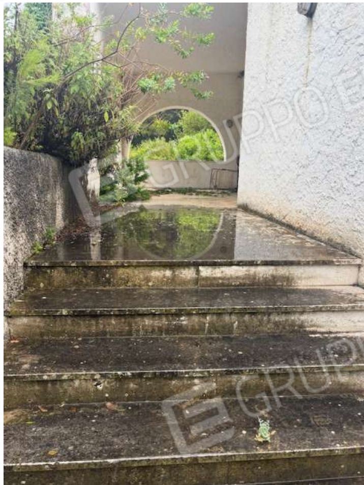
Foto n. 15 – Scala di accesso al portico antistante il fabbricato
