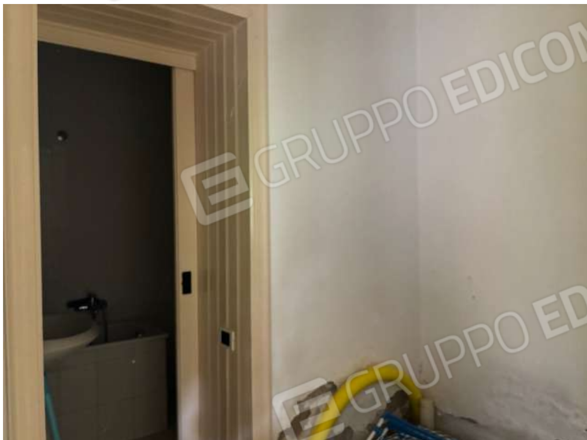
Foto n. 25 – Bagno di servizio e antibagno adibito a ripostiglio
