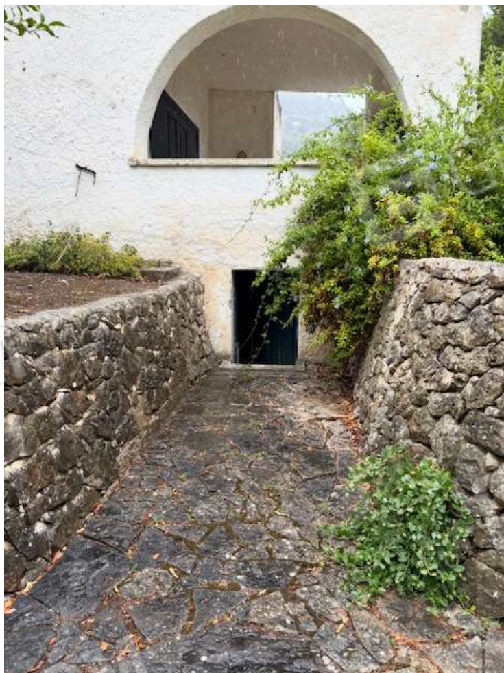
Foto n. 6 – Ingresso al locale-deposito seminterrato
