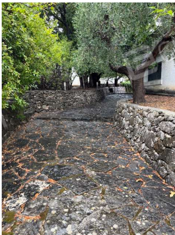
Foto n. 8 – Viabilità veicolare e pedonale limitrofa al fabbricato
