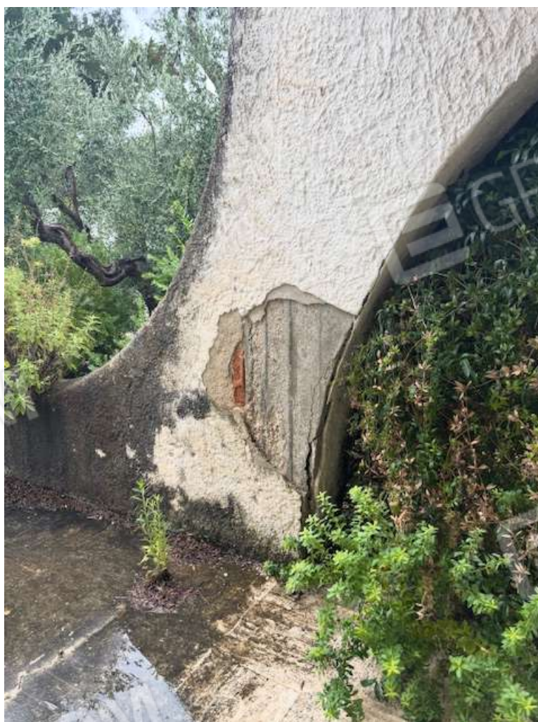
Foto n. 20 – Particolare della struttura del portico antistante il fabbricato
