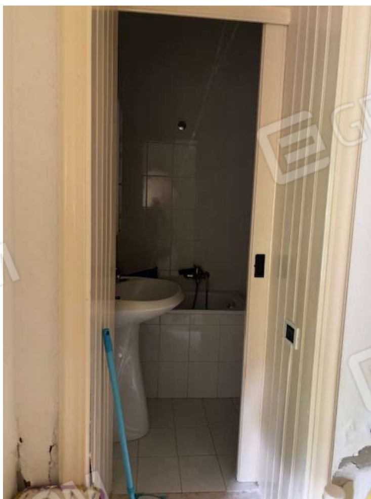
Foto n. 26 – Bagno di servizio e antibagno adibito a ripostiglio
