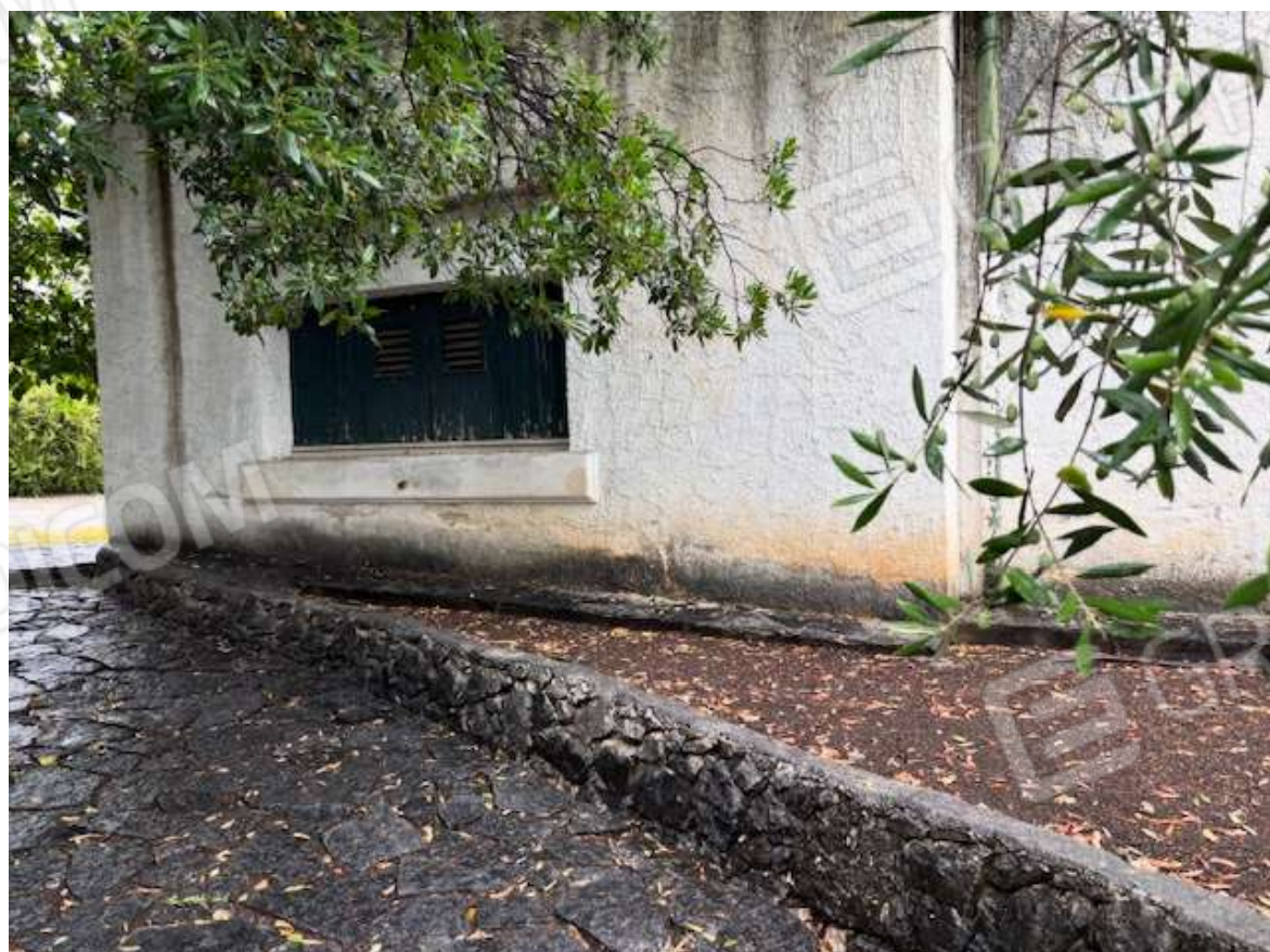
Foto n. 10 – Giardino pertinenziale e viabilità limitrofa al fabbricato
