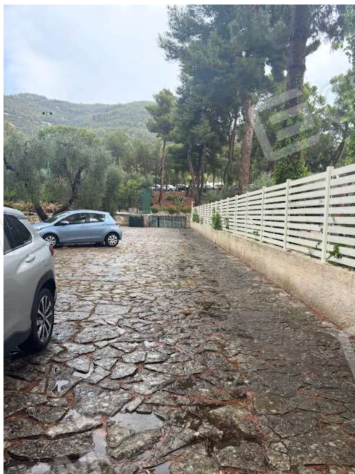
Foto n. 16 – Viabilità a servizio del comprensorio edilizio (vista verso il cancello d'ingresso)
