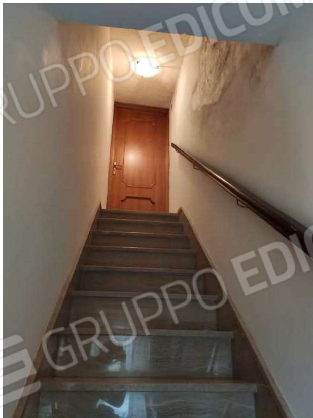
Sub. 4 - Vano scala verso piano 2° [Foto 17]
