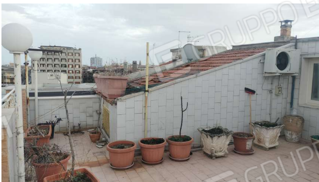
Foto n.18 Volume e terrazzo terzo piano
