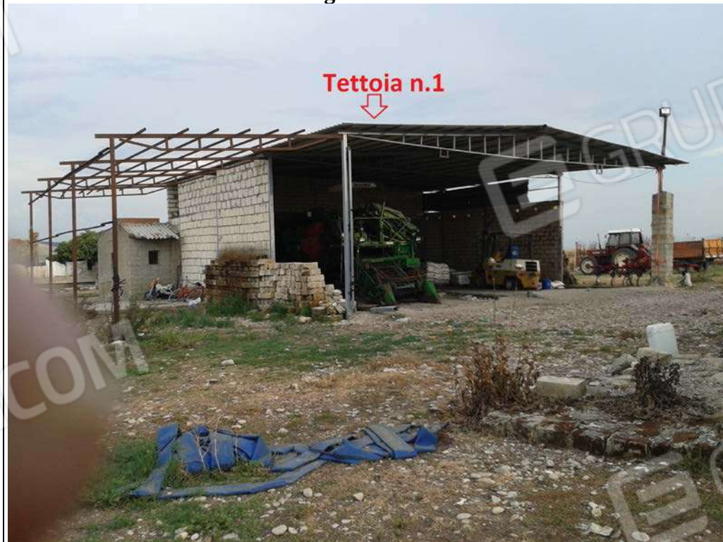
Foto n.46: sull'area adibita a corte, in evidenza i manufatti costituiti dalla tettoia n.1, parte del fabbricato rurale p.lla 206, da notare la precarietà delle tettoie e dei manufatti murari slegati dalle strutture metalliche.
