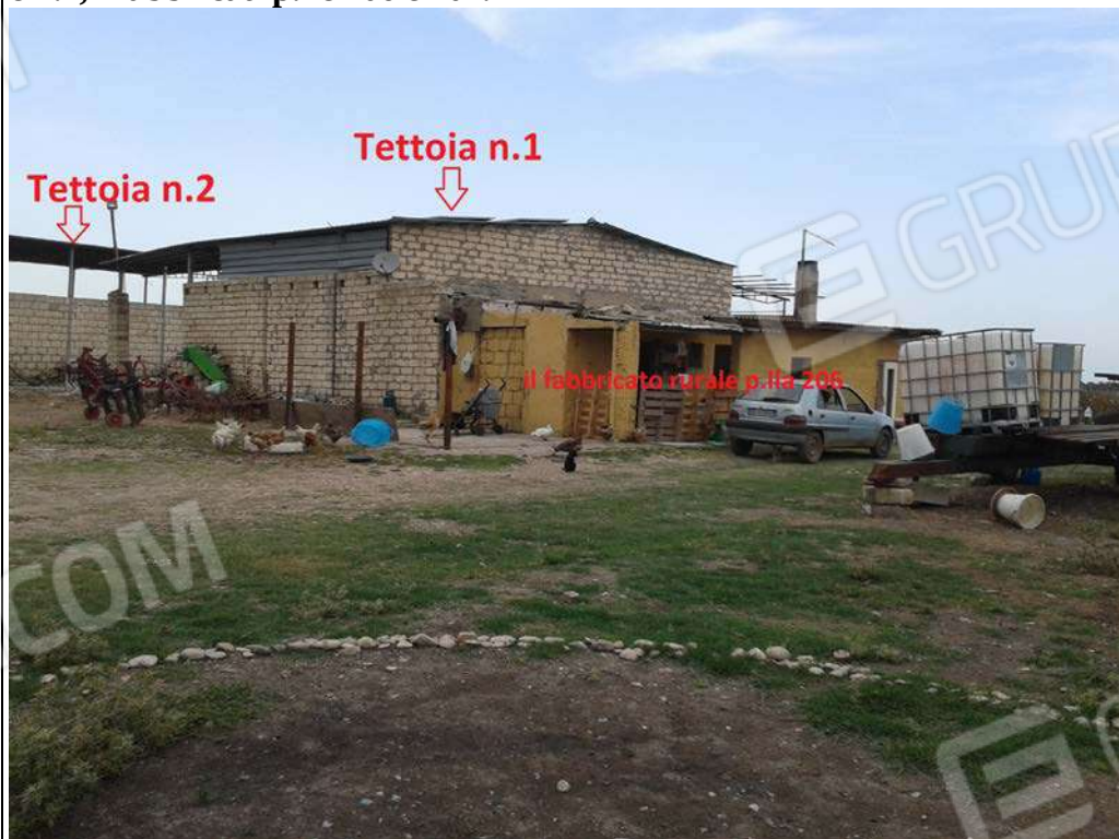
Foto n.44: sull’area adibita a corte, in evidenza i manufatti costituiti dalle tettoie n.1 e n.2, il fabbricato rurale p.lle 206, da notare la precarietà delle tettoie e dei manufatti murari slegati dalle strutture metalliche.
