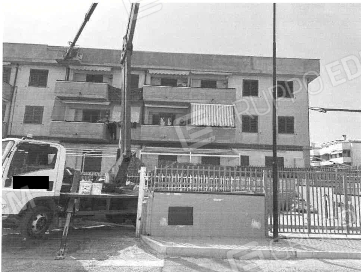
FOTO n. 2 – Vista cancello ingresso box da via Pizzomunno –
