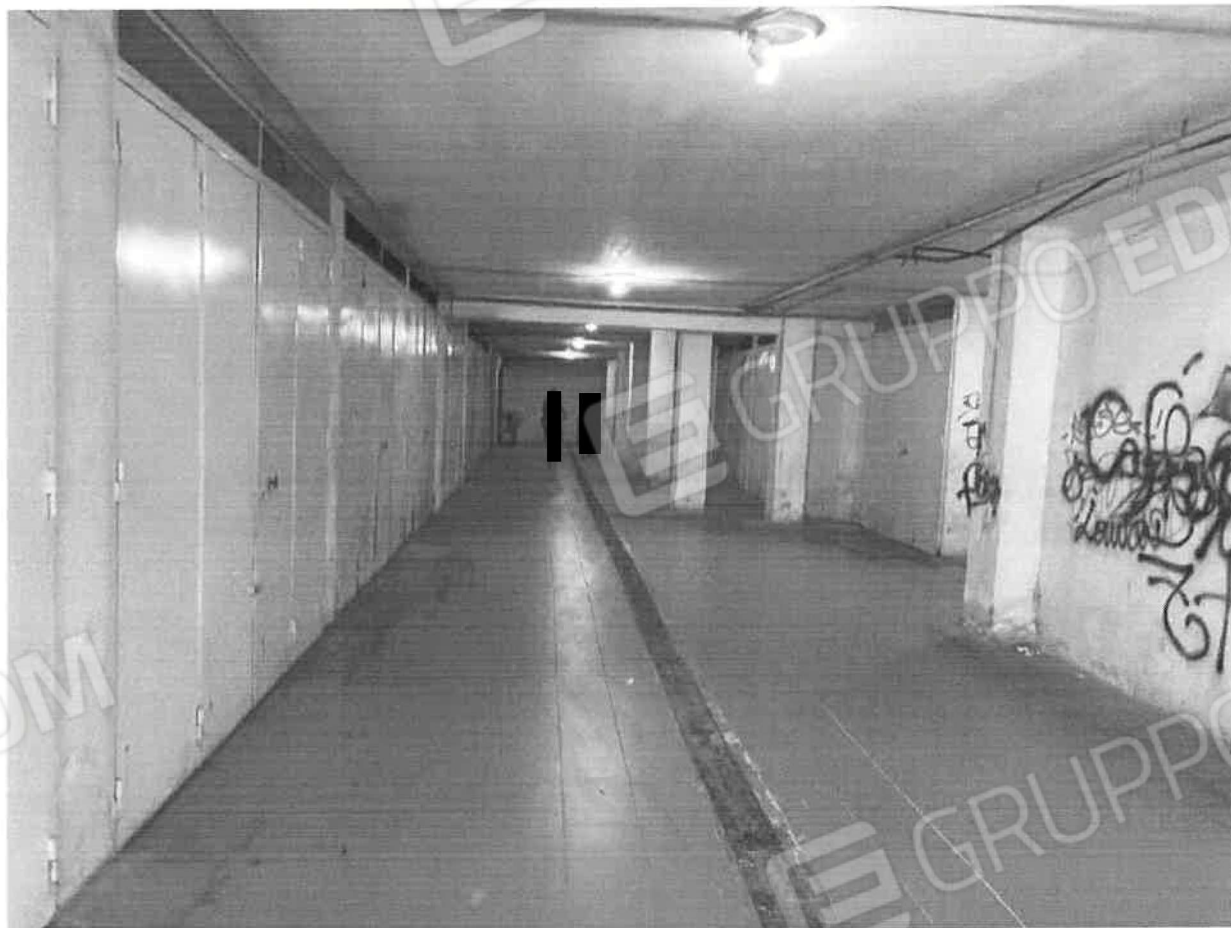
FOTO n. 4 – Particolare corsia accesso box –
