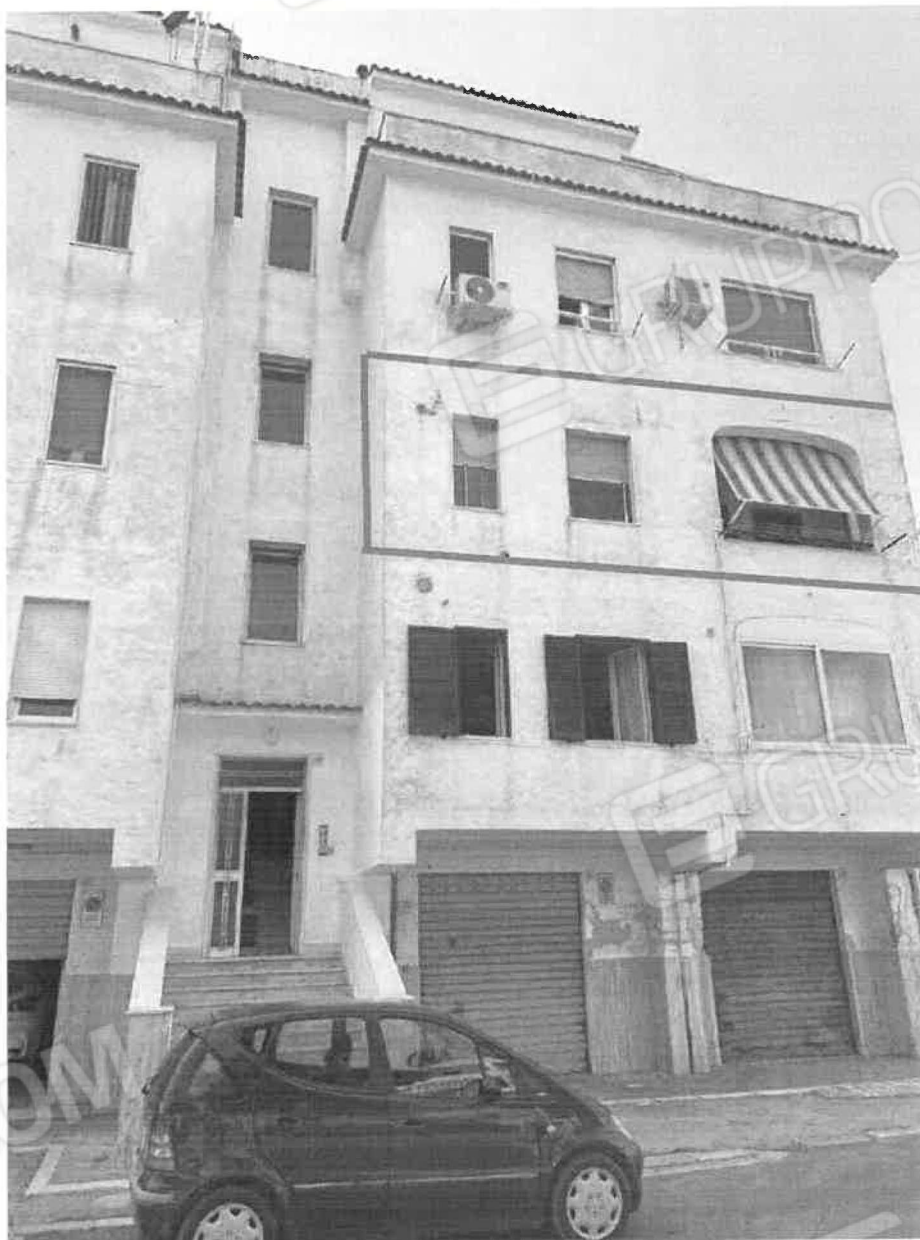
FOTO n. 1 – Vista esterna abitazione lotto n.3 –
