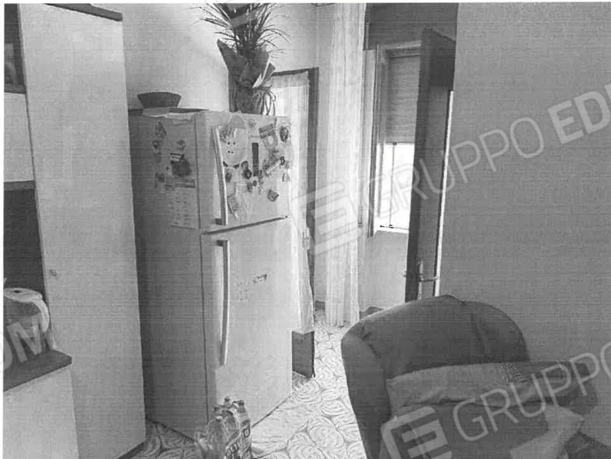
FOTO n. 6 – Particolare infissi esterni –
