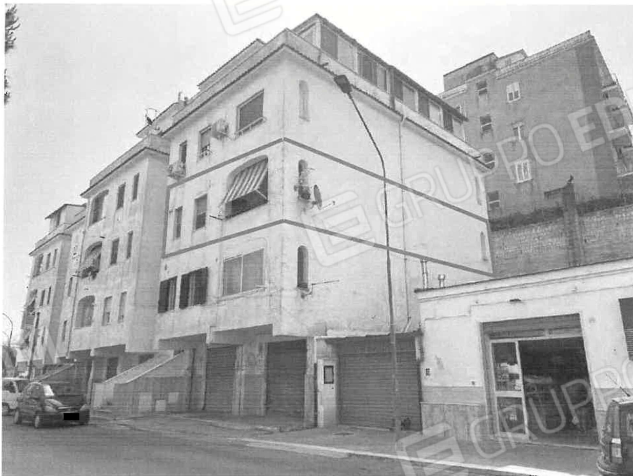
FOTO n. 2 – Vista esterna lotto n.3 -
