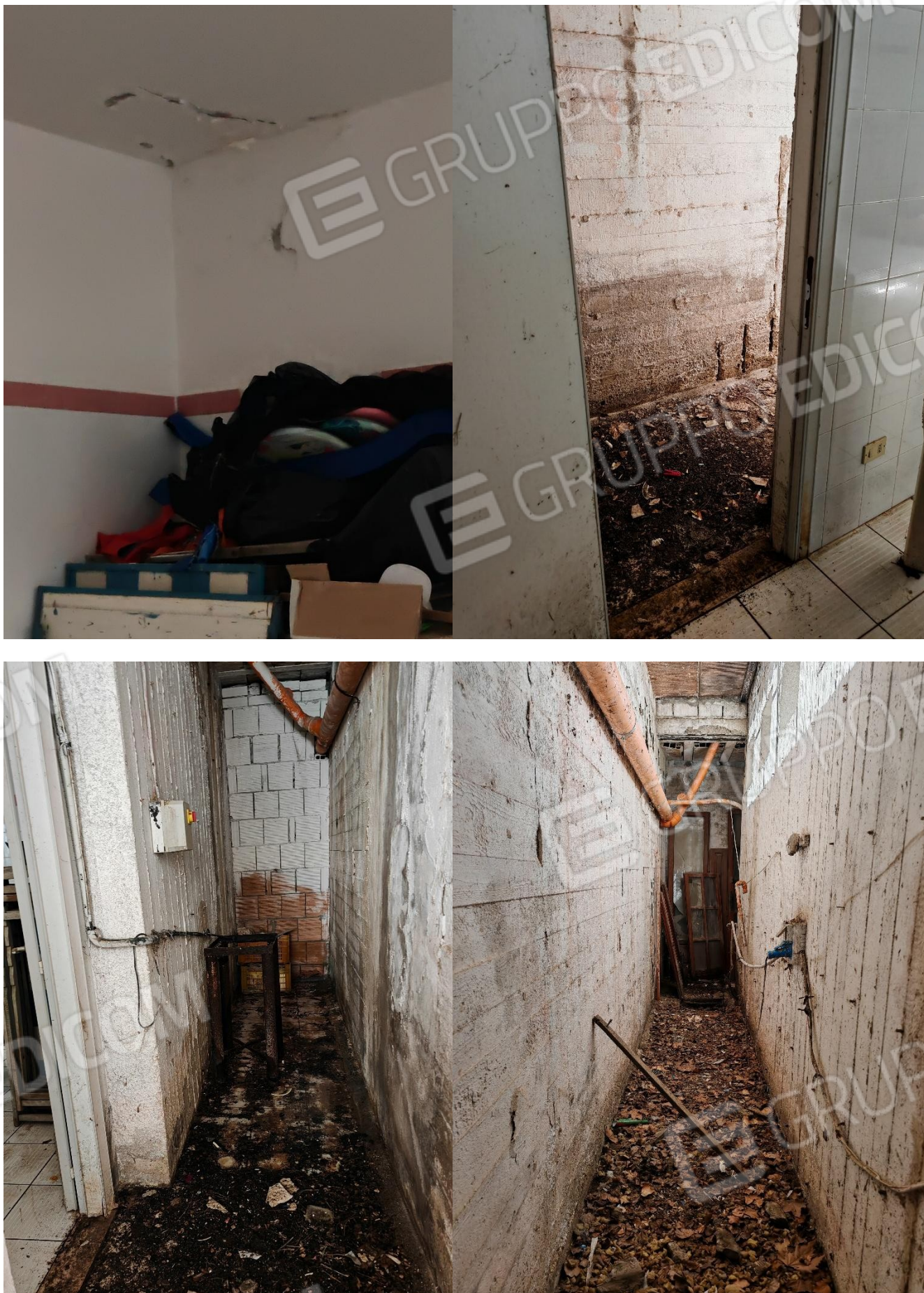
Figura 9: interno Locale Commerciale (cavedio)
