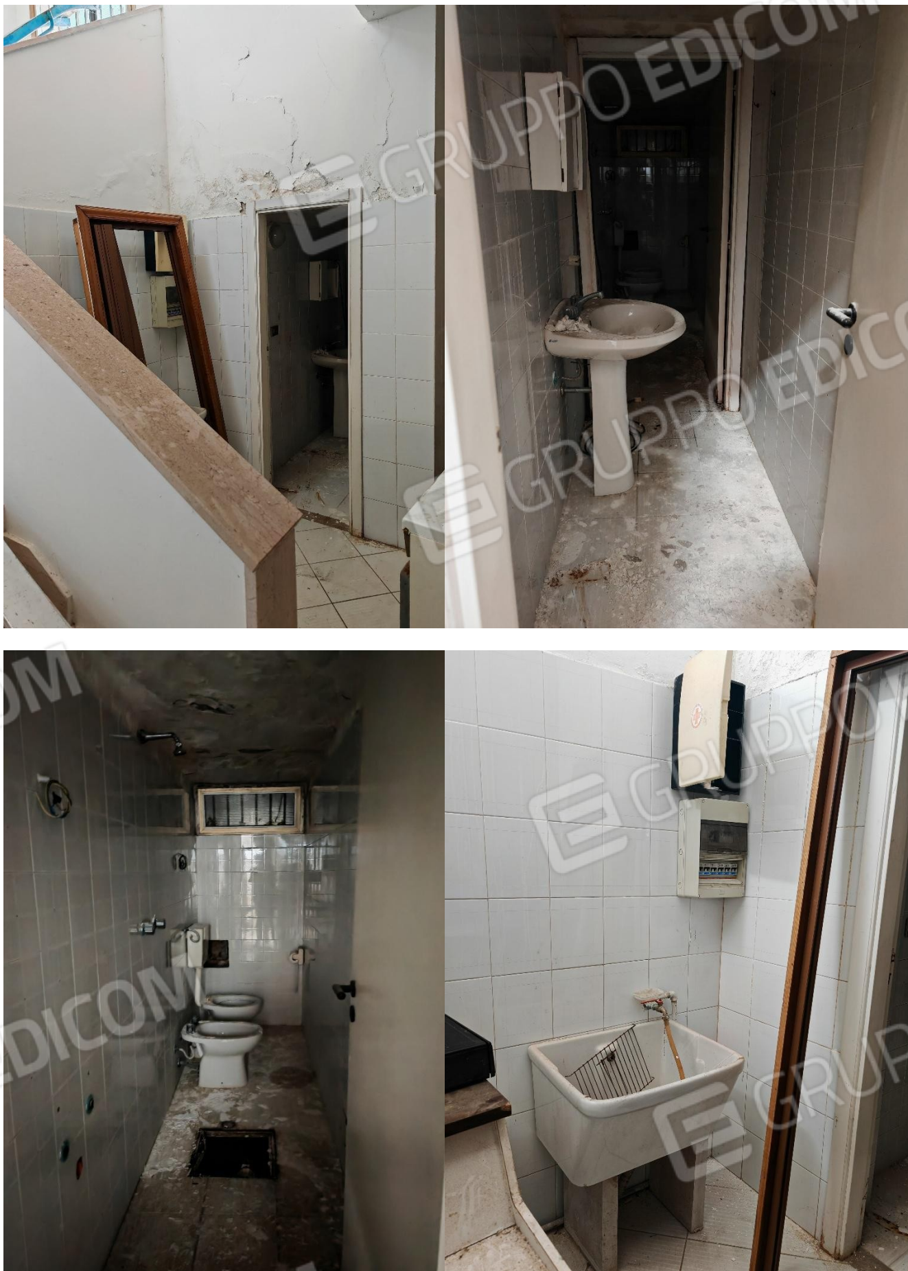
Figura 8: interno Locale Commerciale (zona wc)
