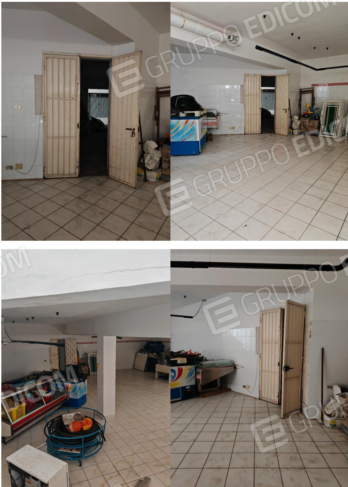
Figura 6: interno Locale Commerciale
