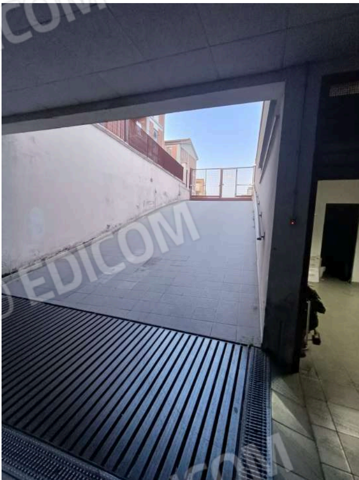
Rampa condominiale di accesso all'autorimessa
