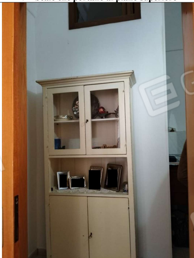
8 – Primo piano: vecchio vano scala murato
