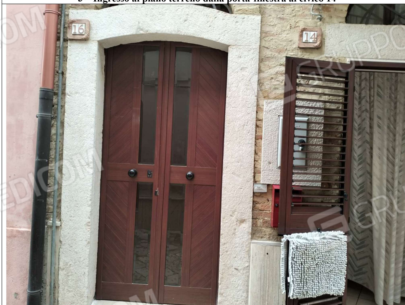
4 – Ingresso al primo e secondo piano da portoncino privato
