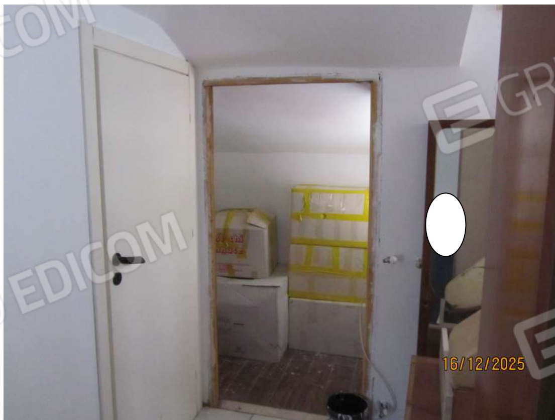
FOTO N. 24 – SCORCIO DEL RIPOSTIGLIO RICAVATO NELLA ZONA DEL SOTTOTETTO ESTERNO
