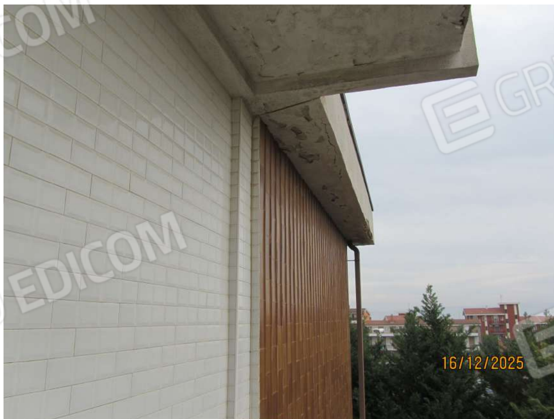
FOTO N. 18 – STATO MANUTENZIONE CORNICIONE
