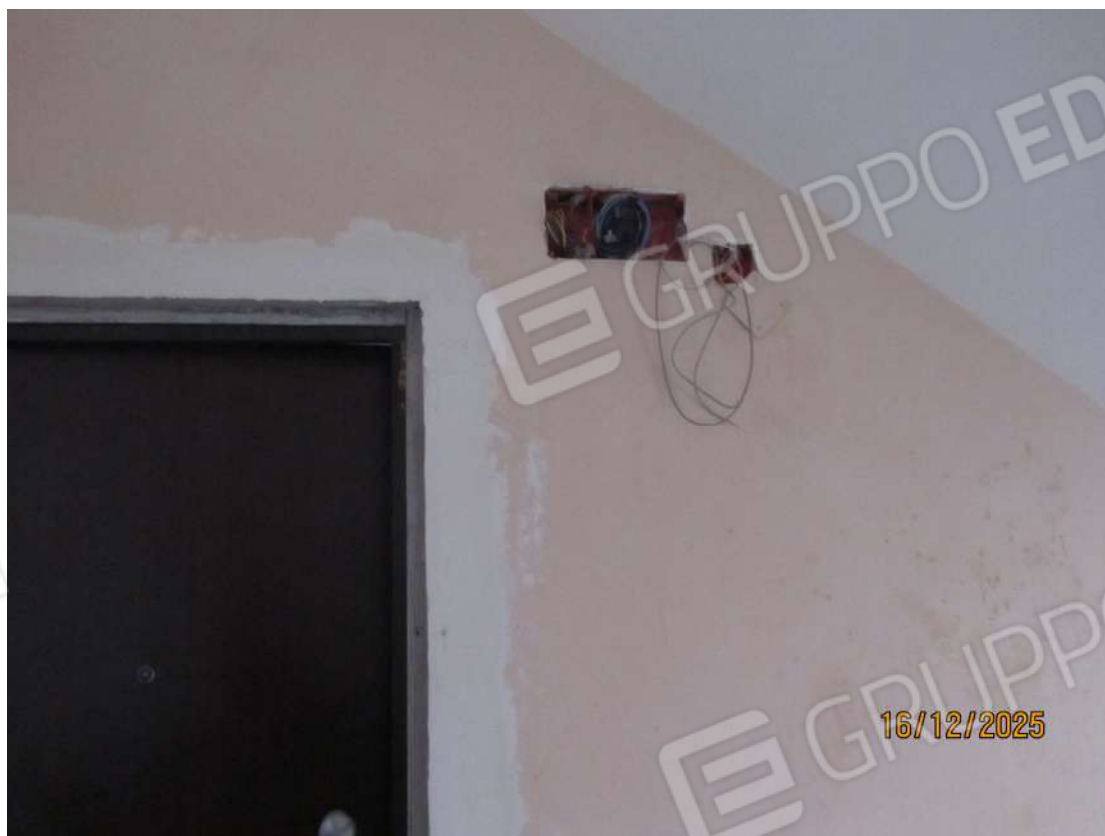
FOTO N. 7 – IDEM C.S. – PARTICOLARE CASSETTA IMPIANTO ELETTRICO
