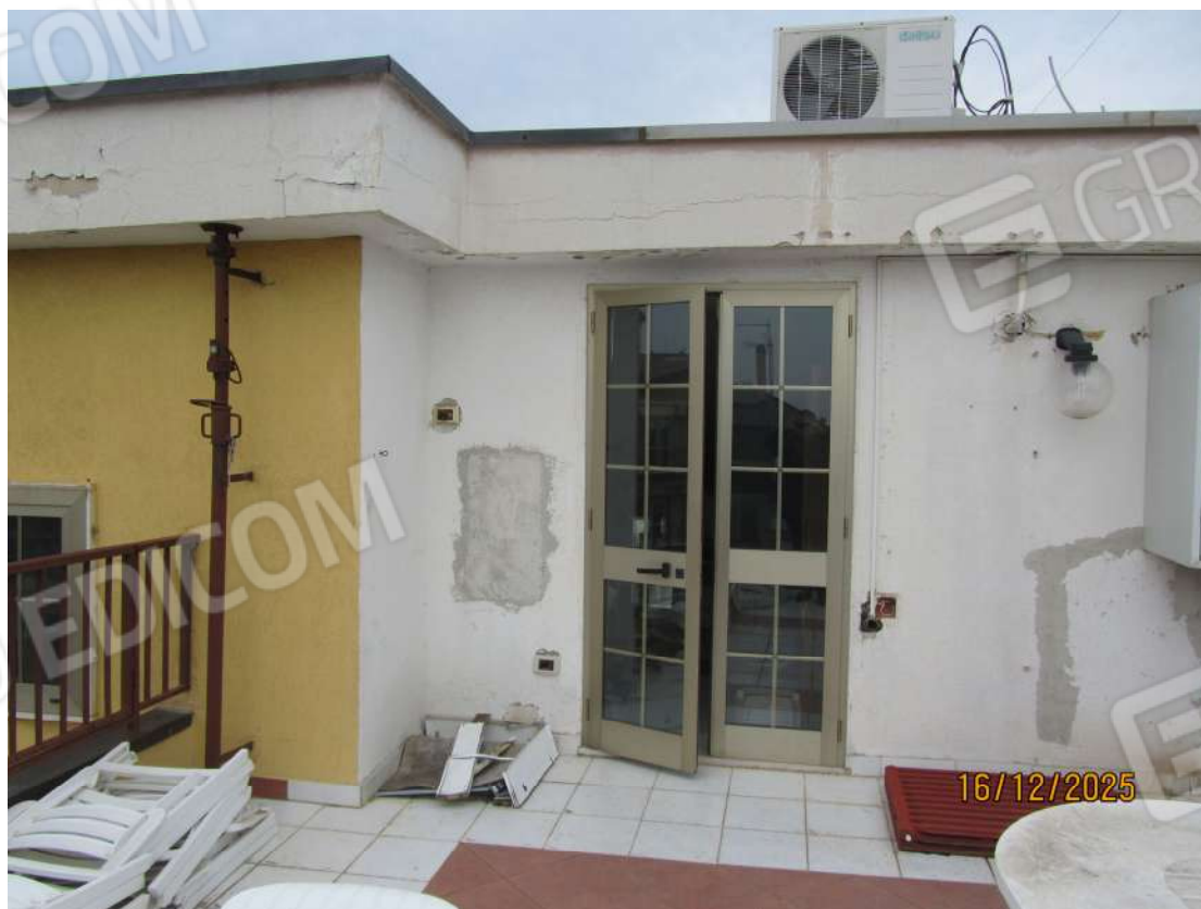
FOTO N. 26 – IDEM C.S. – PORTAFINESTRA DI ACCESSO
