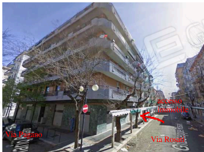
Vista del fabbricato
