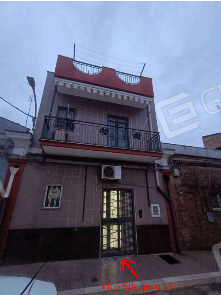
Vista del fabbricato
