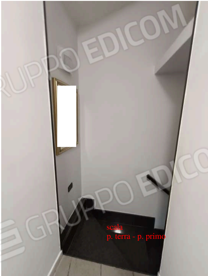
Viste interno immobile (piano primo)
