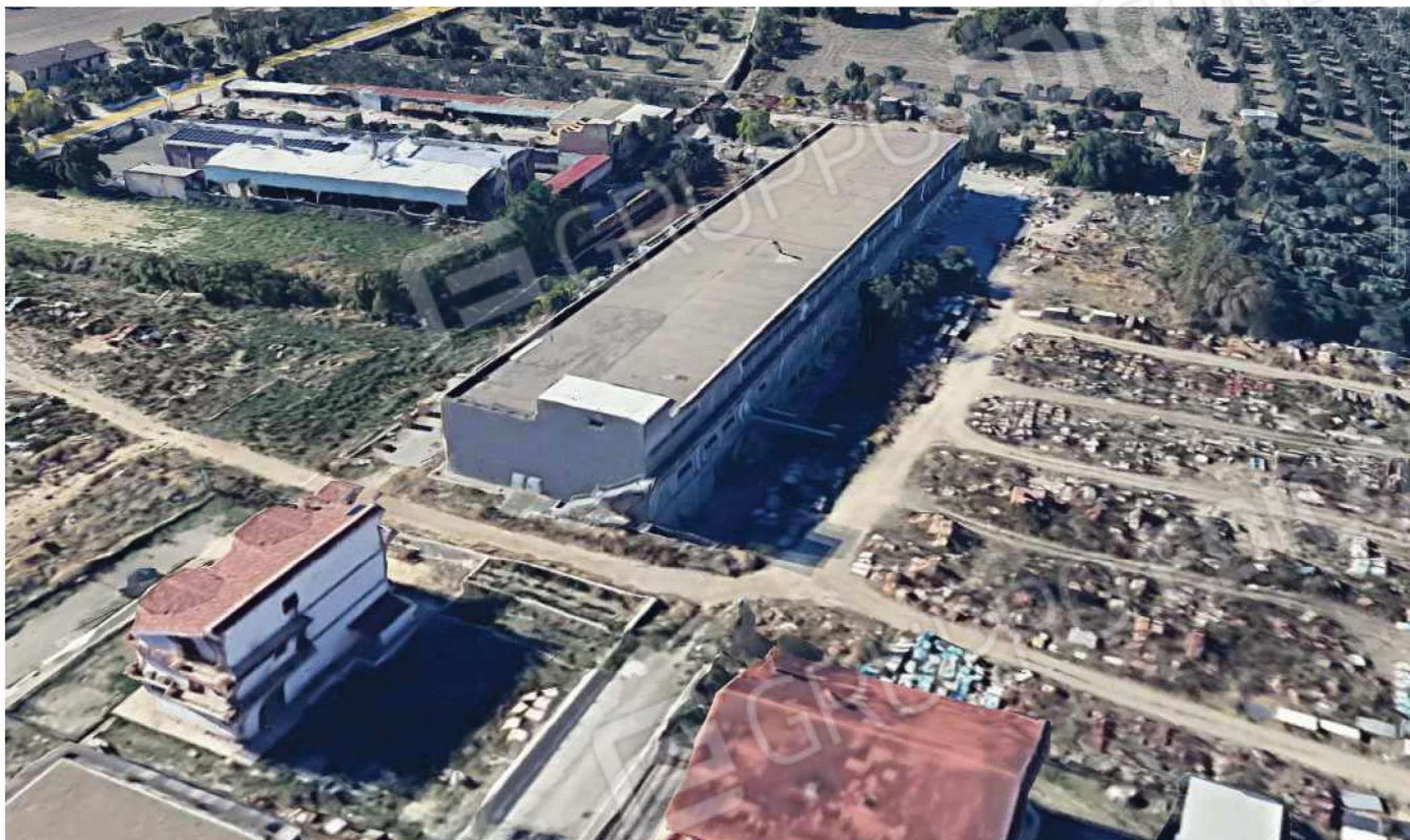
FOTO N° 1 – Vista aerea del capannone (da Google Earth™).
