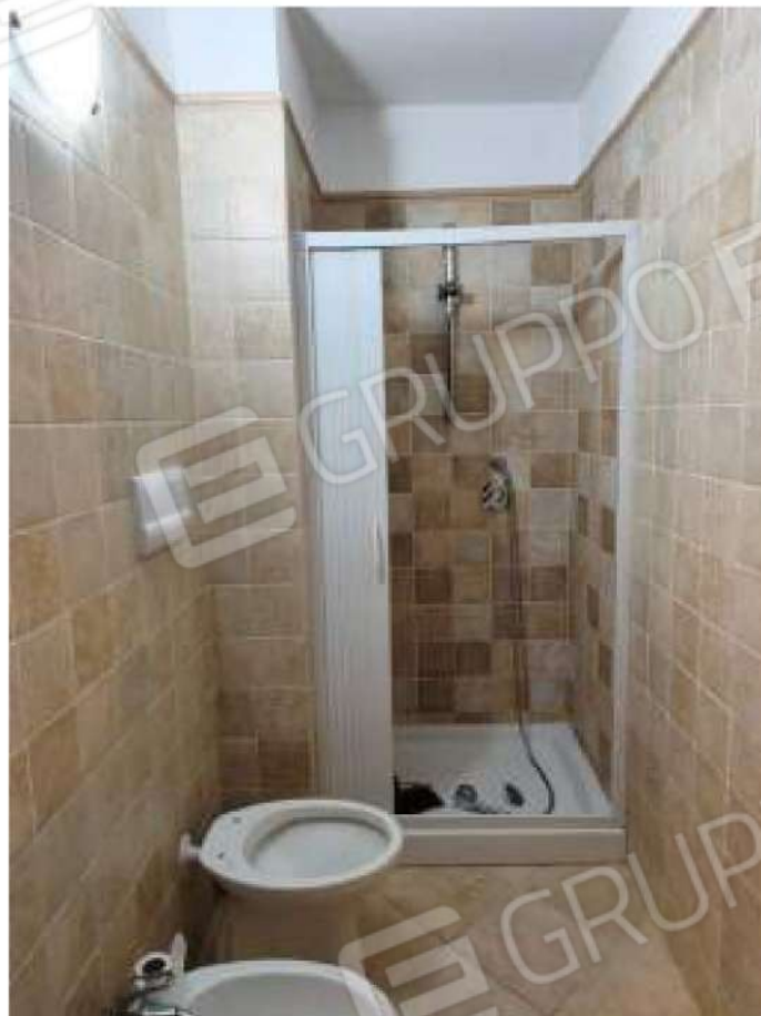
Foto n.25 (Bagno piano seminterrato)
