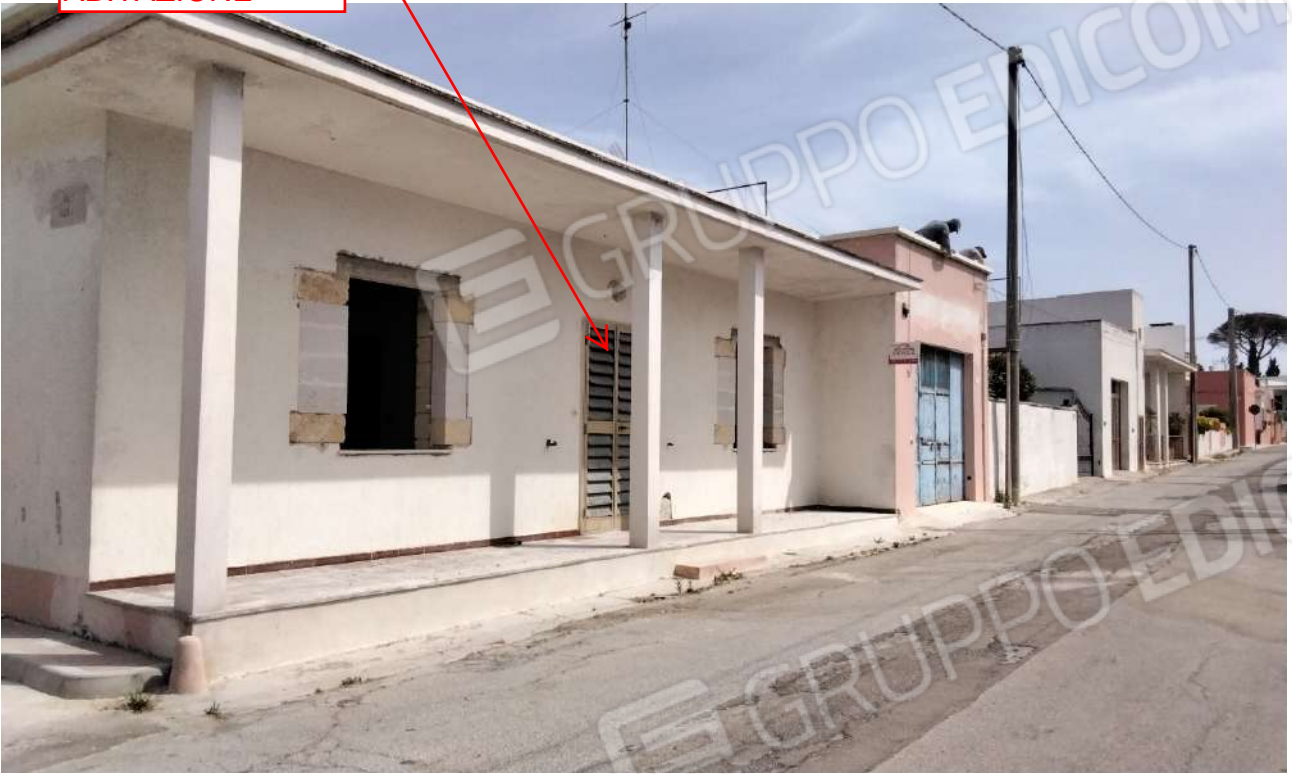
FOTO N.01 PARTICOLARE PROSPETTO SU VIA VERONA
