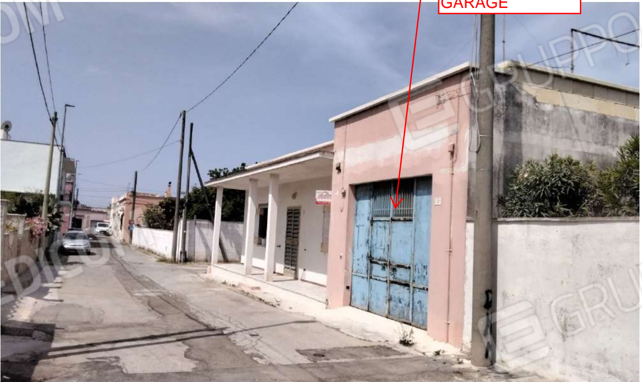
FOTO N.2 PARTICOLARE PROSPETTO SU VIA VERONA
