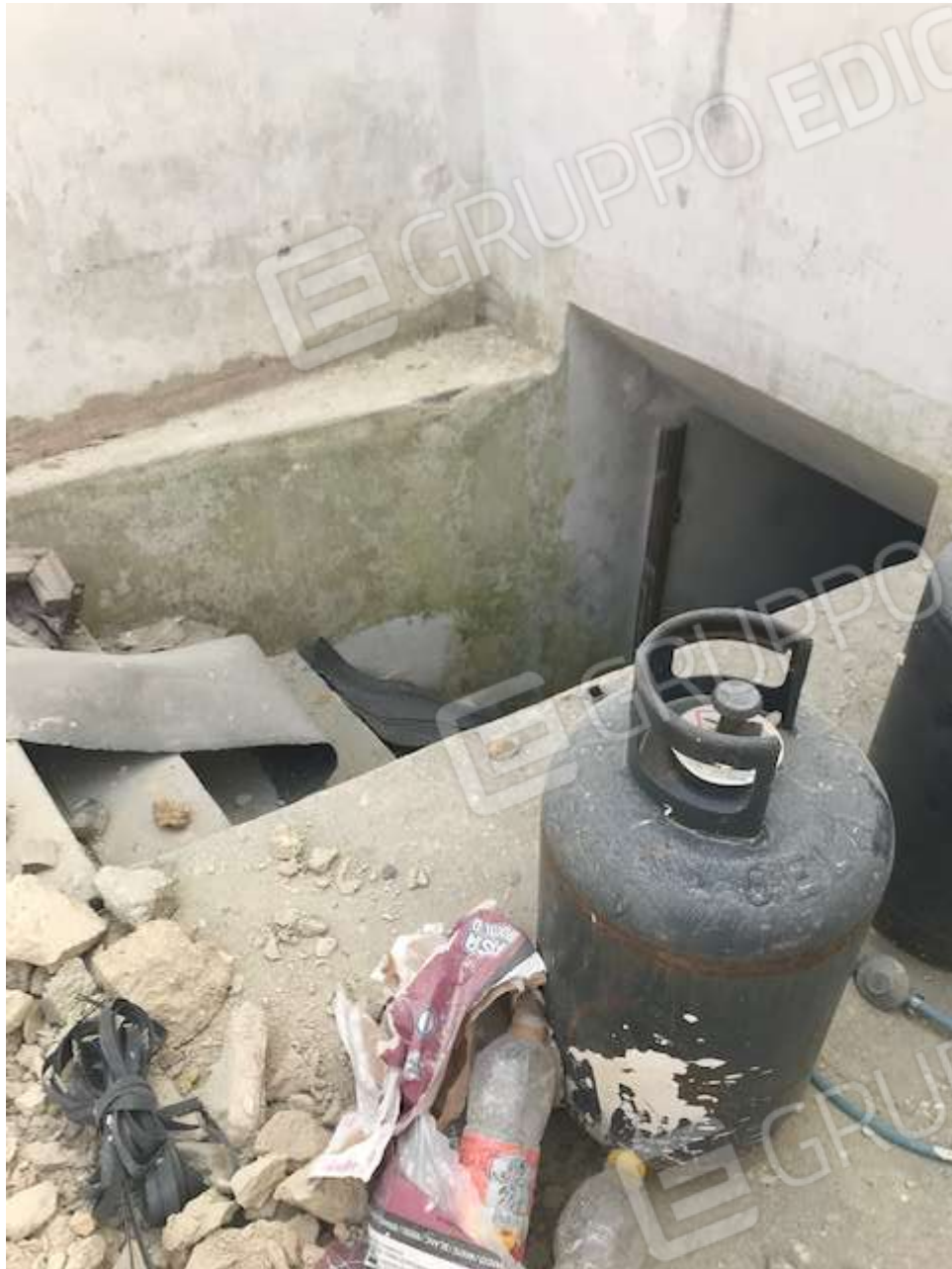
FOTO N.14 PARTICOLARE ACCESSO VUOTO SANITARIO INTERRATO
