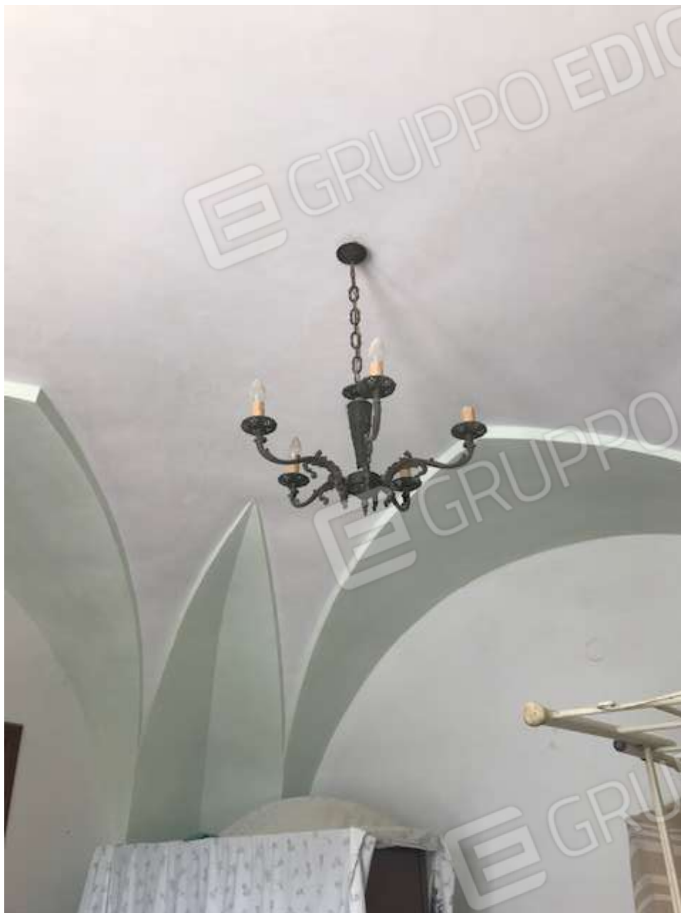
FOT N.10 PARTICOLARE VOLTE INTERO ABITAZIONE
