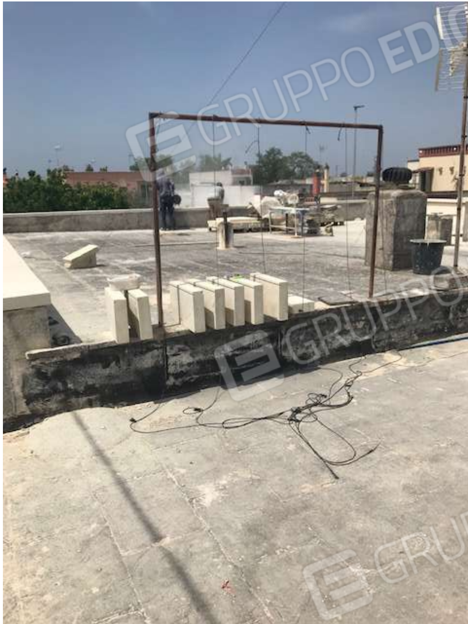
FOTO N.06 PARTICOLARE LASTRICO SOLARE
