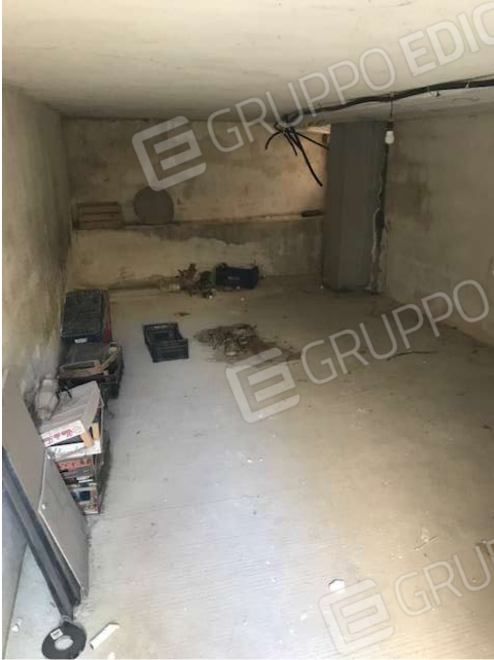
FOTO N.15 PARTICOLARE INTERNO VUOTO SANITARIO
