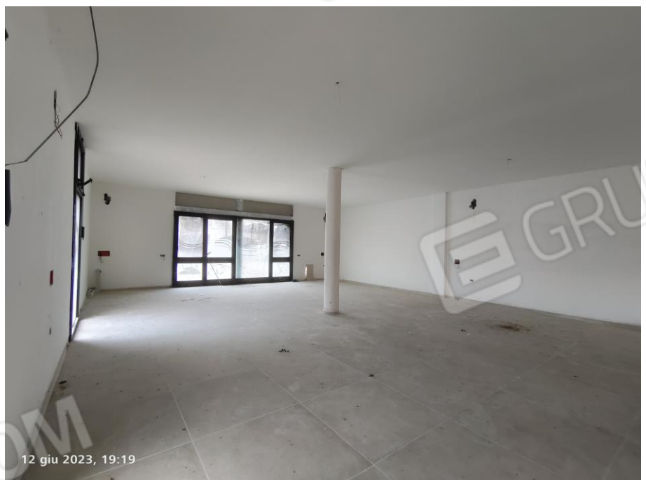
Interno locale commerciale
