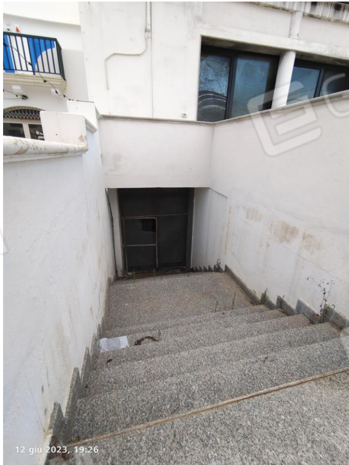
Scala di accesso locale deposito da C.so C. Colombo
