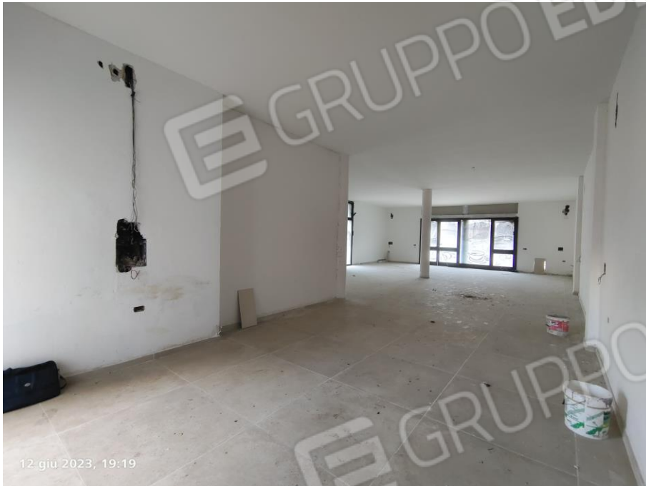
Interno locale commerciale
