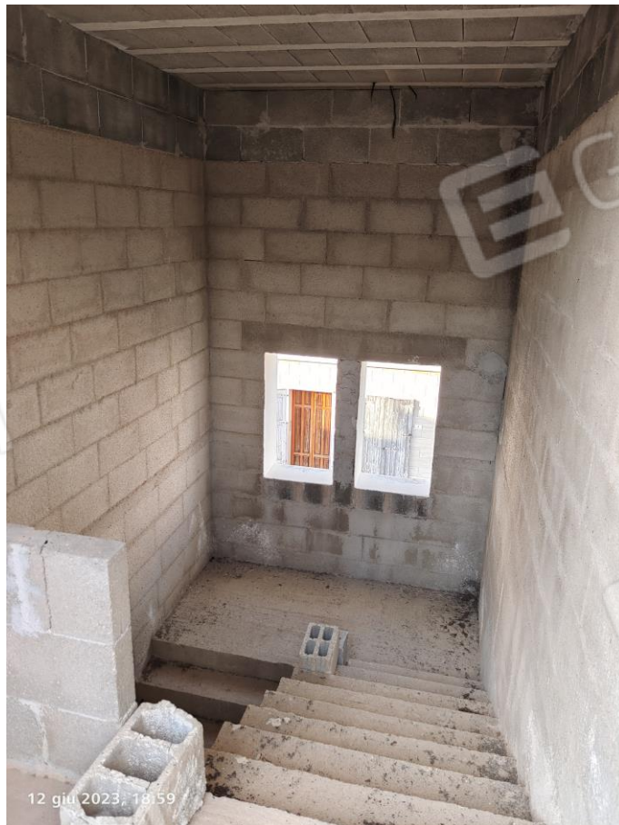
Interno vano scala
