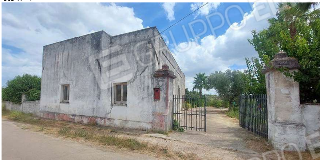
Prospetto esterno – Strada Vicinale Fontana
