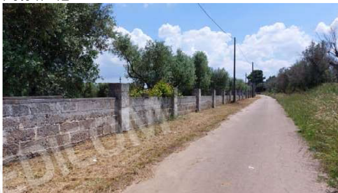
Recinzione su Strada Vicinale Fontana
