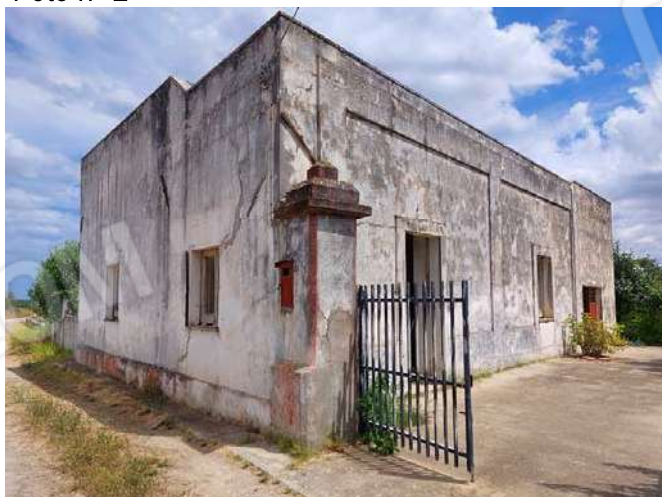
Ingresso a cortile e terreno
