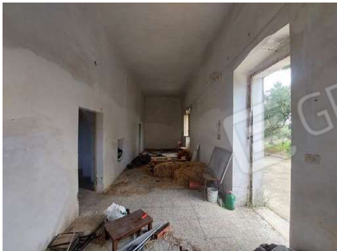
Ingresso e disimpegno
