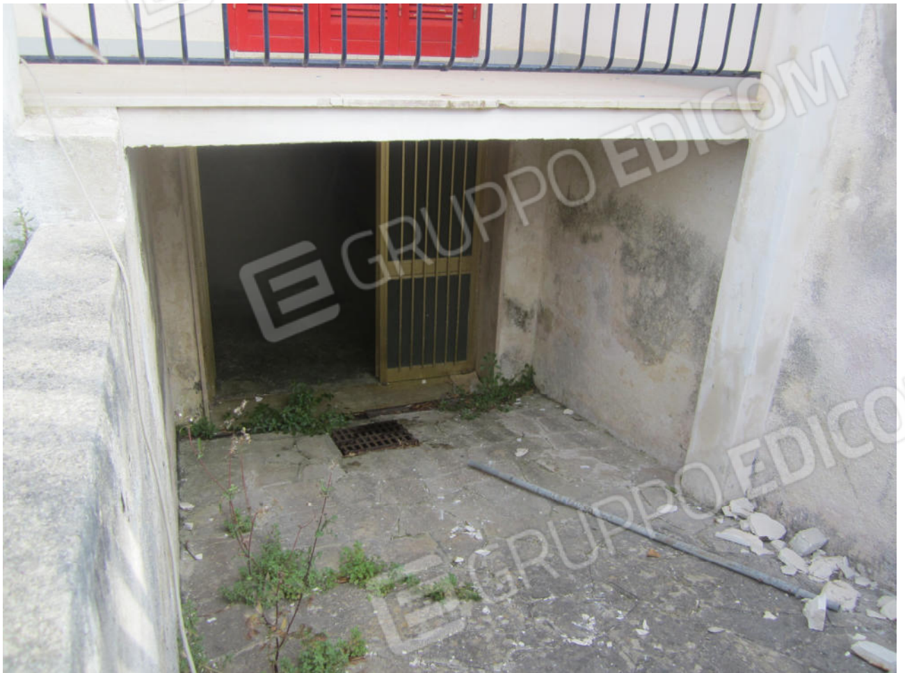
Foto n. 19 – rampa accesso al garage
