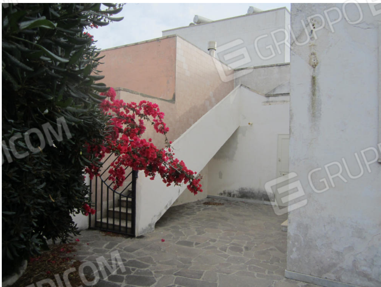
Foto n. 16 – scala di accesso ai lastrici solari
