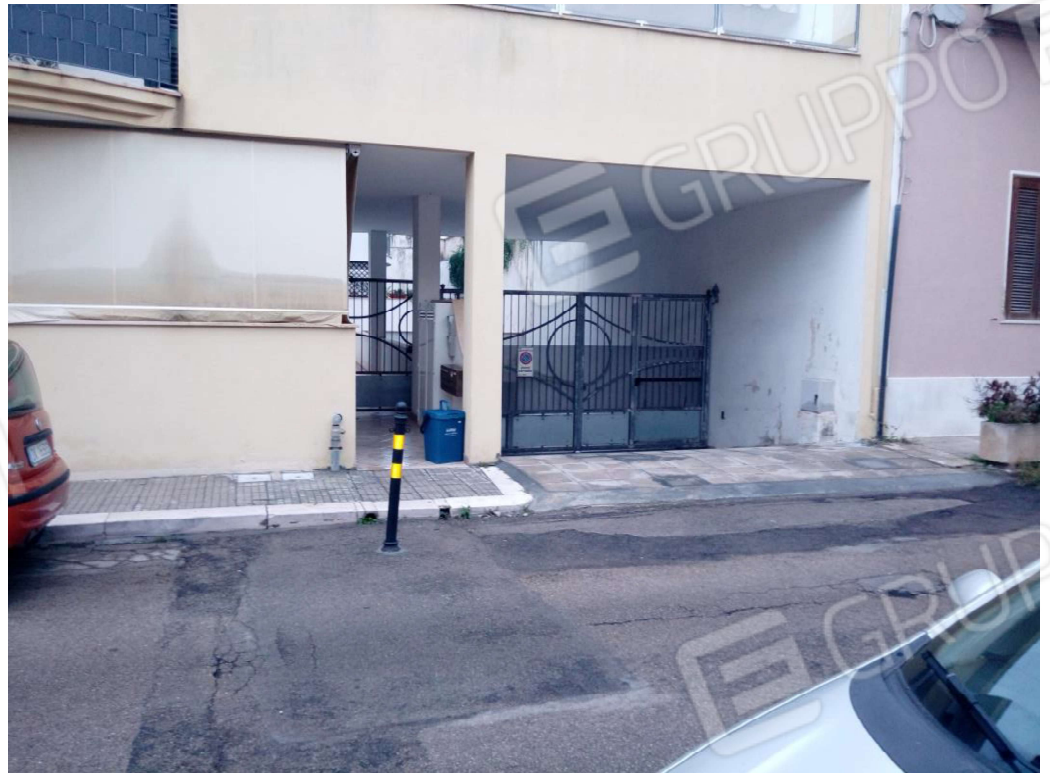
Ingresso - prospetto principale
