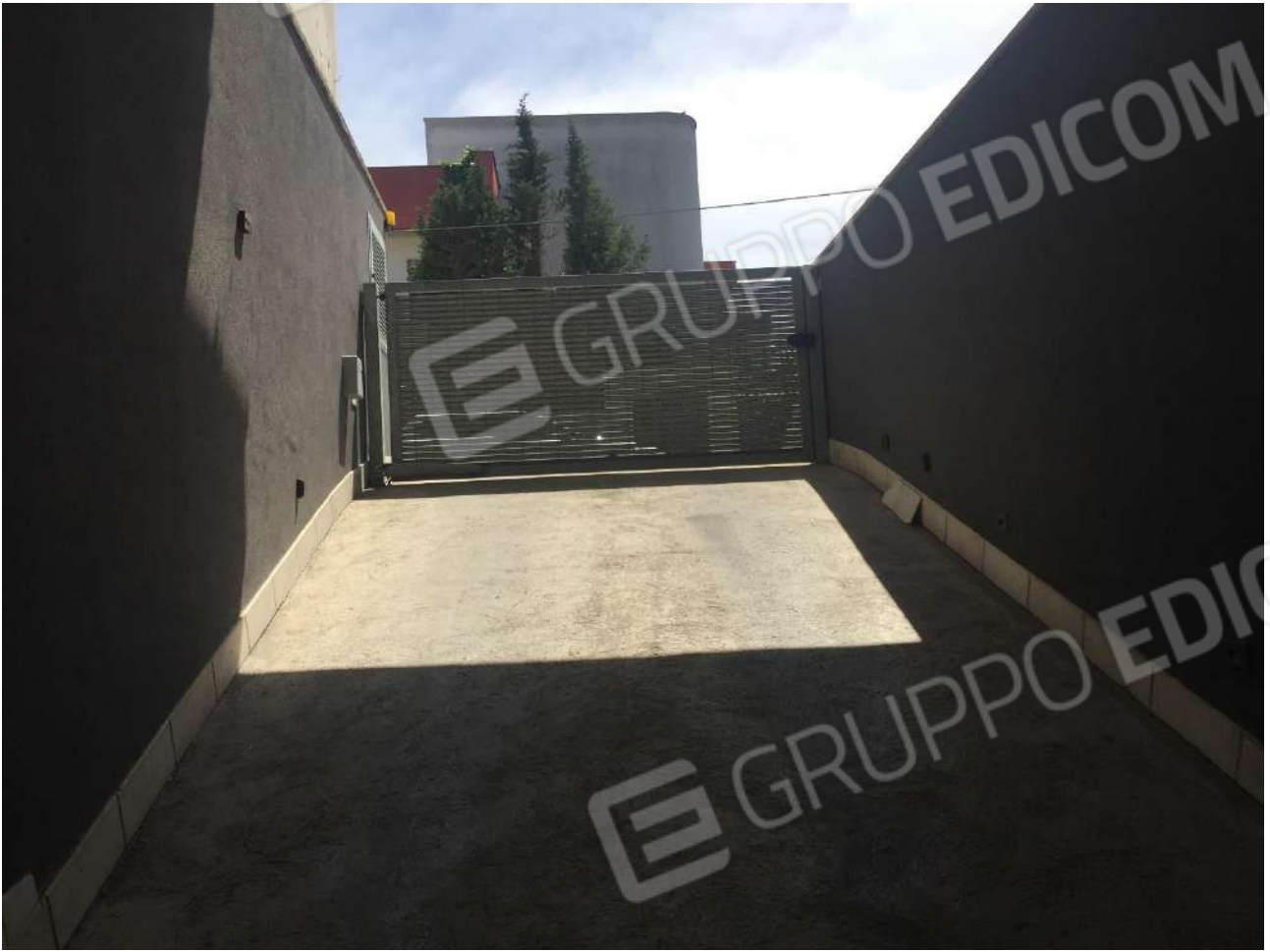
FOTO N. 5 accesso da rampa lato scala C
