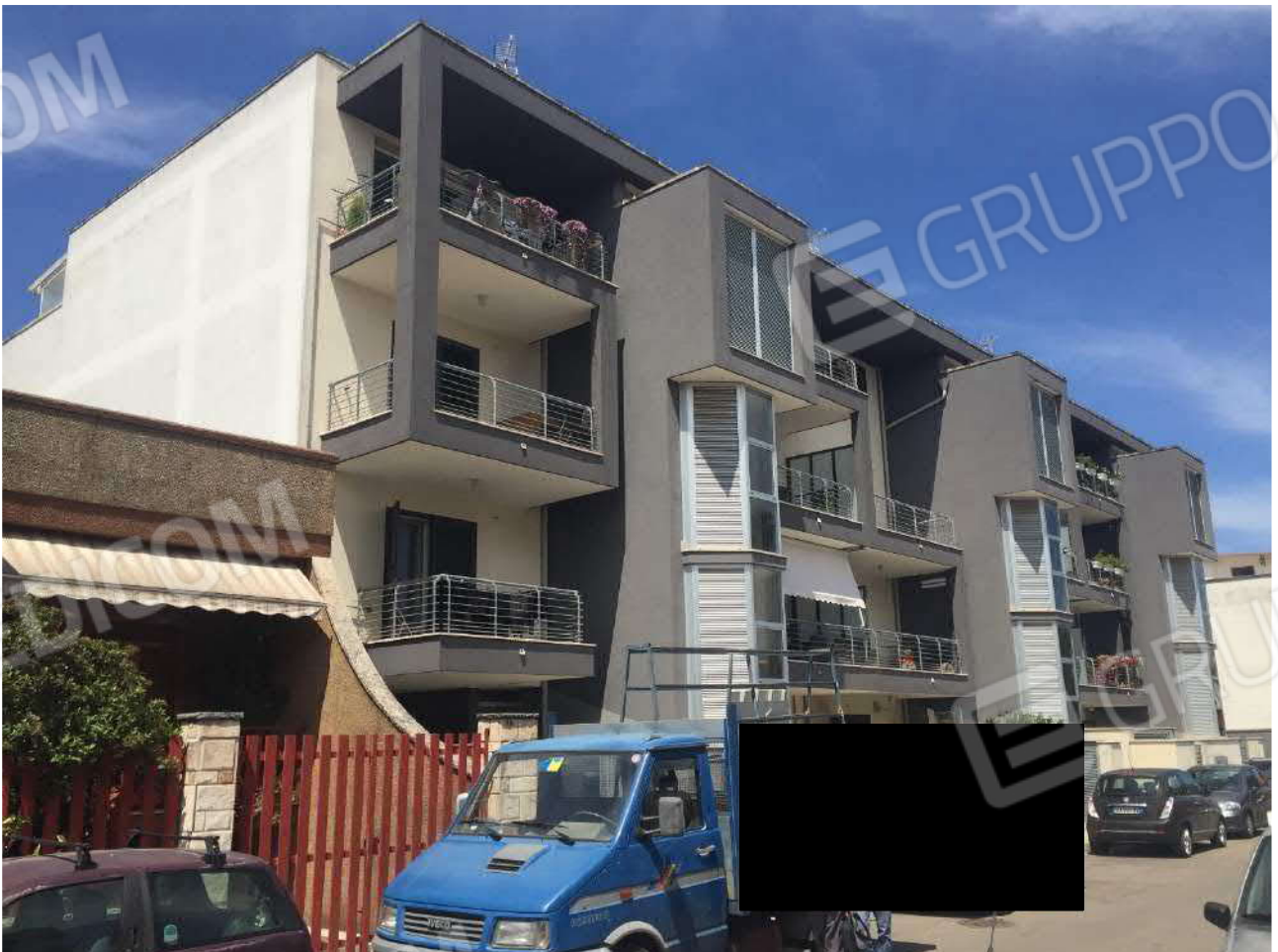
FOTO N. 2 Prospetto principale su via Sele
