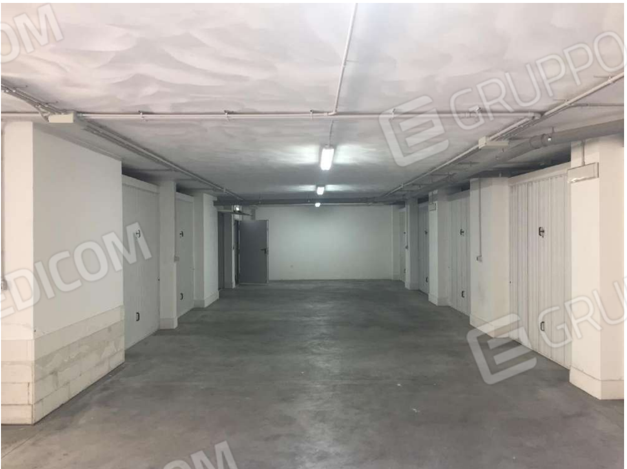
FOTO N. 6 vista box (terzo a sx) da spazio manovra
