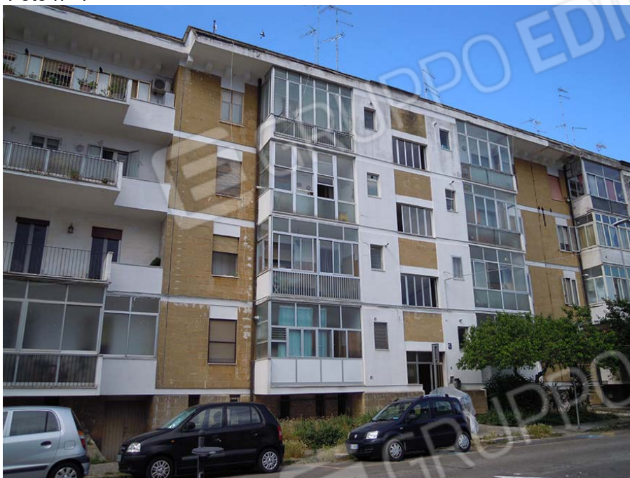
Prospetto su Via Isonzo.
