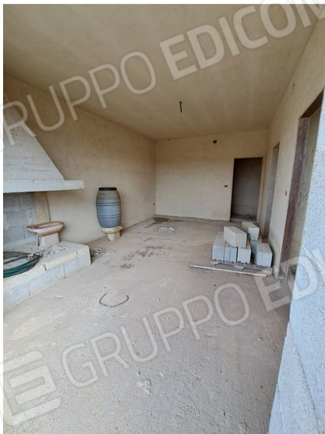
LOTTO 6 Piano Primo (sub. 13) unità immobiliare a destinazione uffici/esposizione
