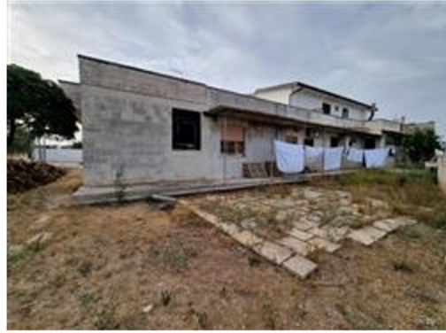
UNITA' 2 - Retro prospetto
