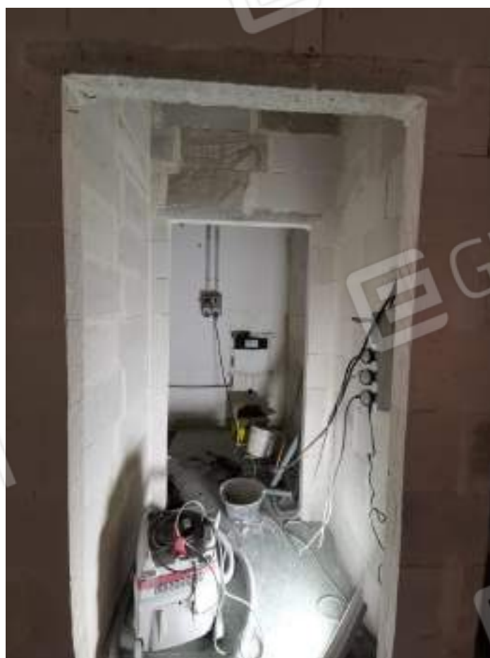
Figura 17: Lavori in corso per realizzazione WC piano terra
