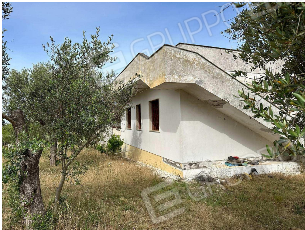
Foto 07: Vista esterna – Prospetto retrostante
