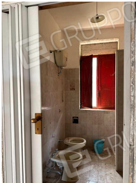
Foto 13: Vista interna – Vano bagno
