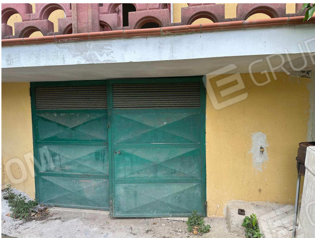
Foto 02: Vista esterna – Vano deposito
