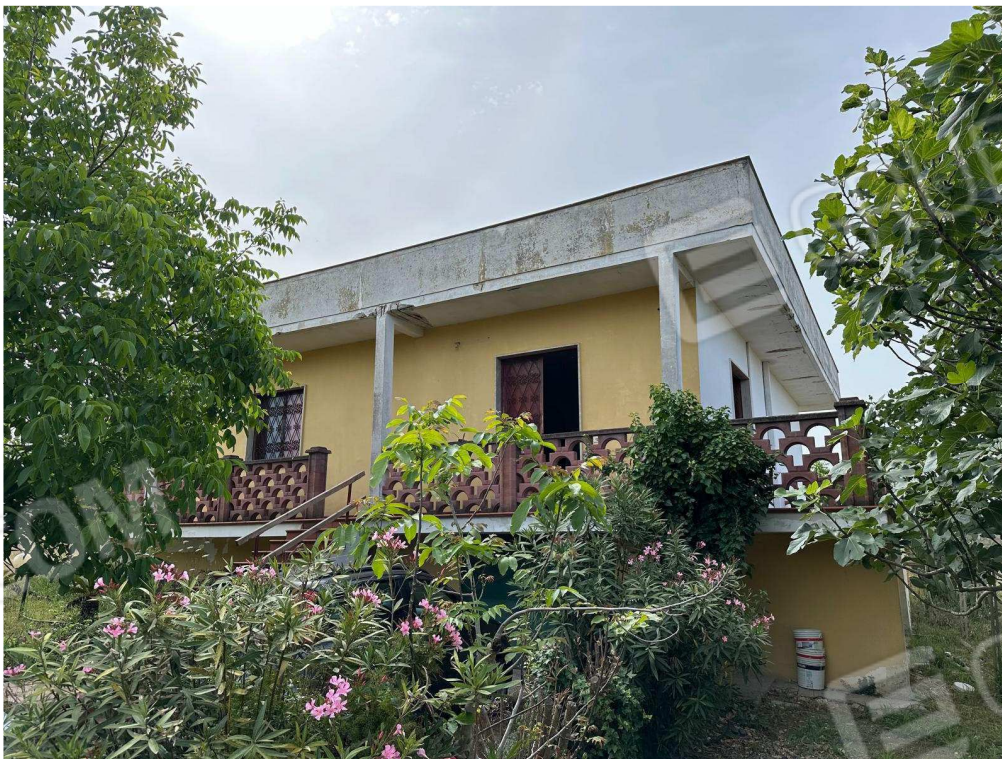
Foto 04: Vista esterna – Prospetto frontale
