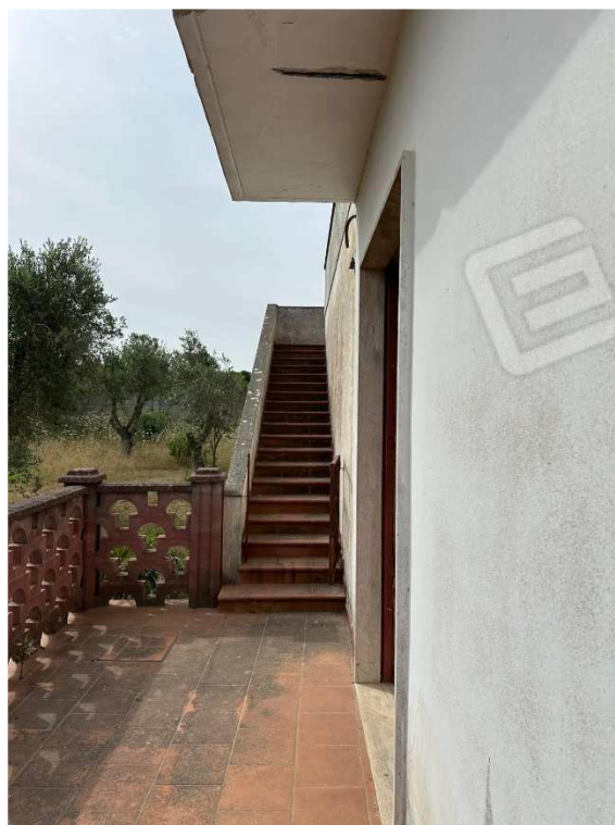
Foto 08: Vista esterna – Scala accesso terrazza
