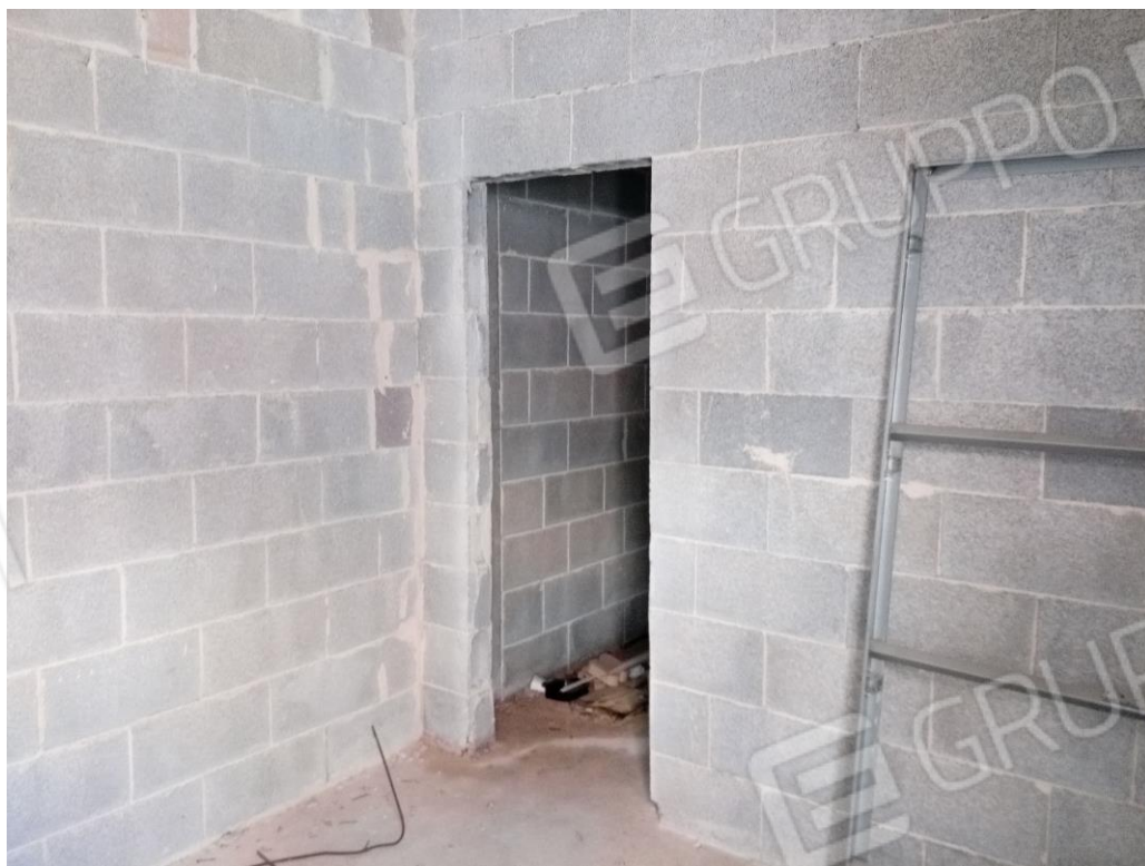
Vano antistante – piano interrato
