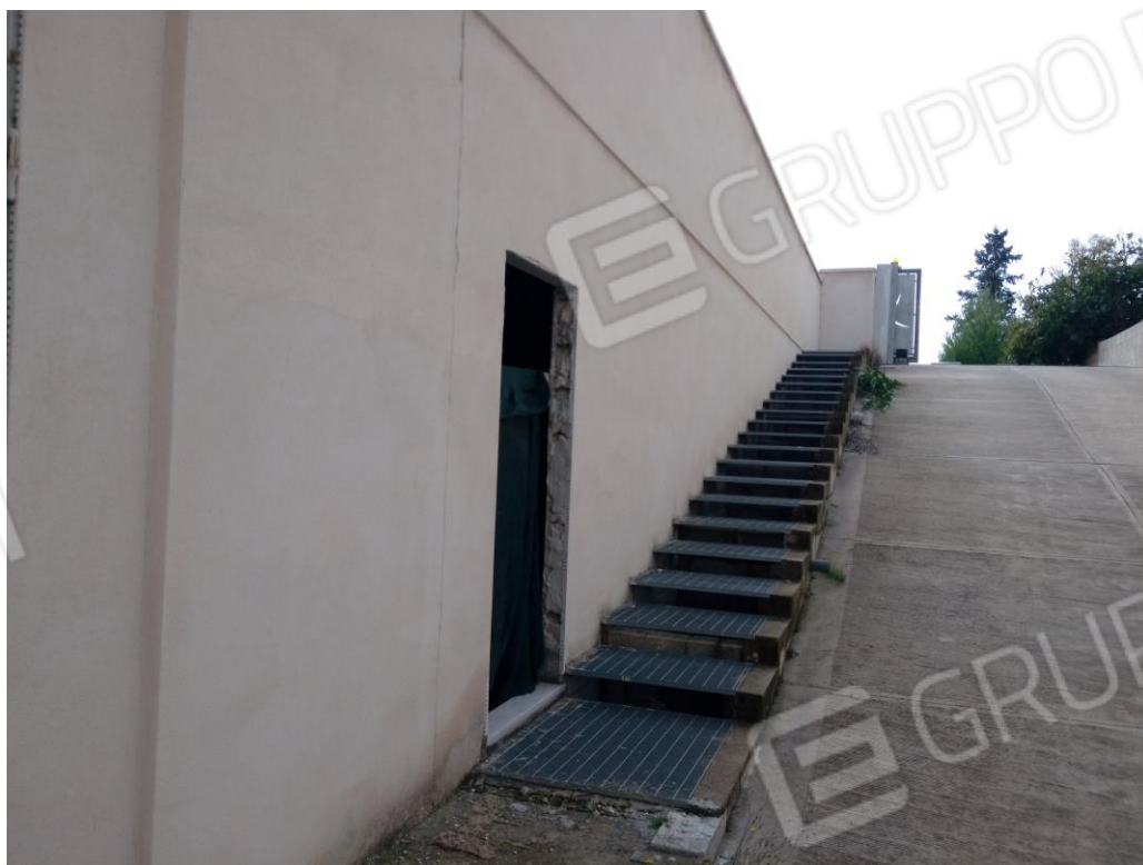
Ingresso locale – piano interrato
