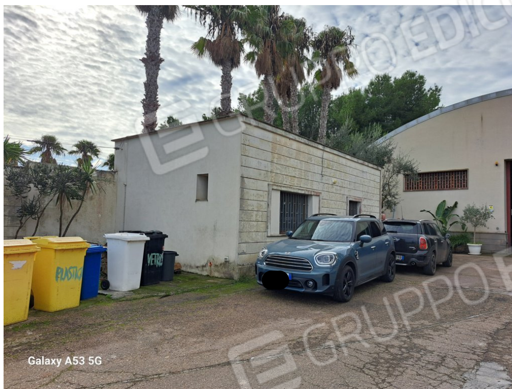
FOTO 3 Fabbricato uffici amministrativi
