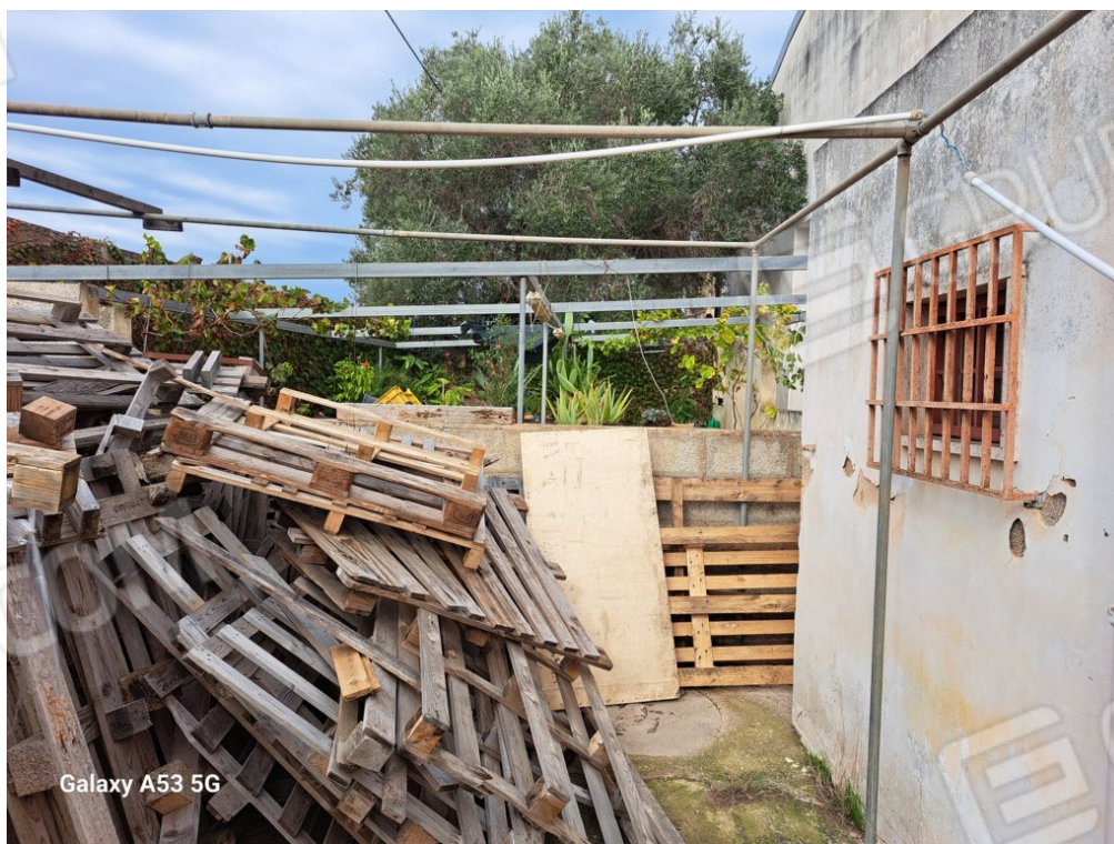
FOTO 6 Area retrostante il capannone-autorimessa
