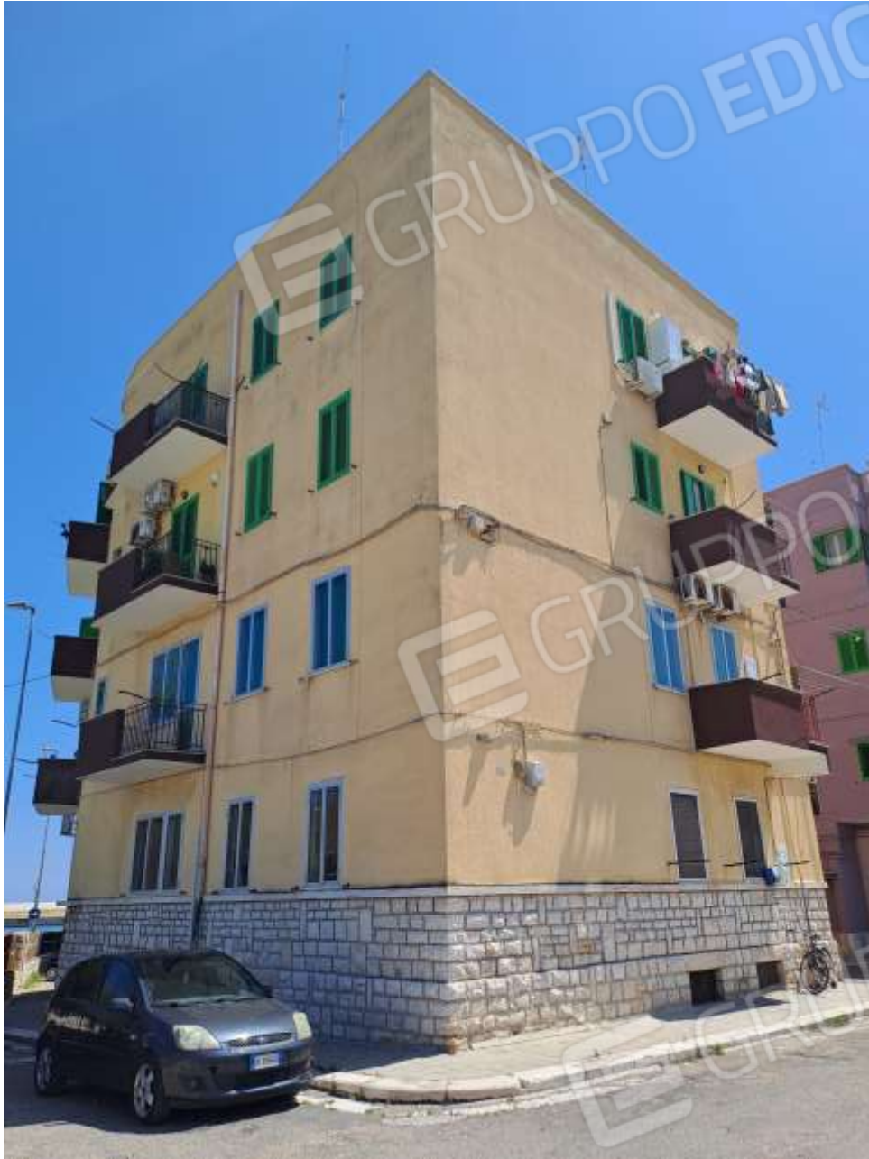
Figura 3 - vista dell'edificio del quale fa parte l'u.i. oggetto di perizia
