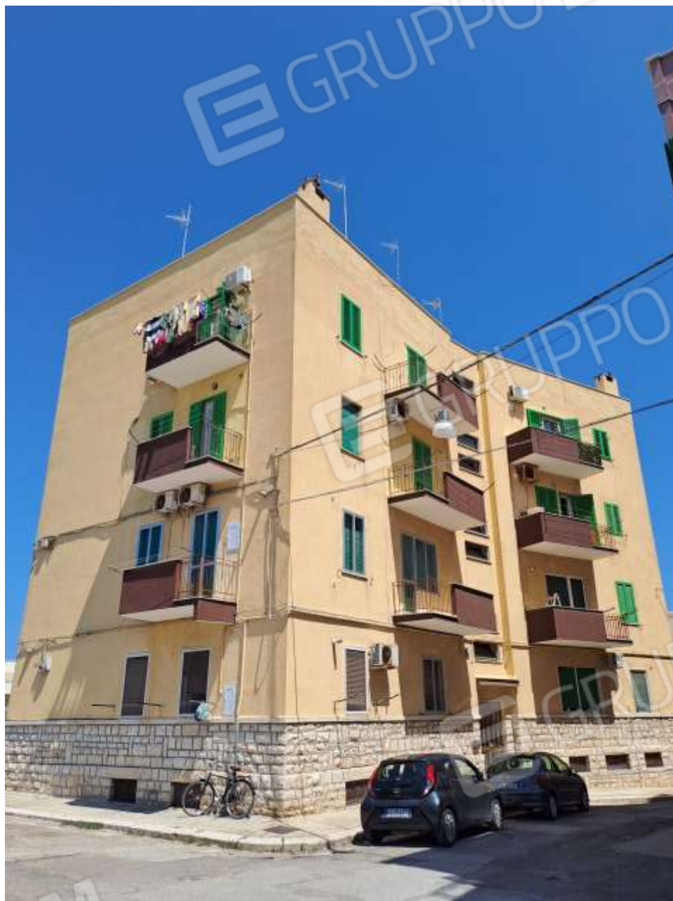
Figura 2 - vista dell'edificio del quale fa parte l'u.i. oggetto di perizia
