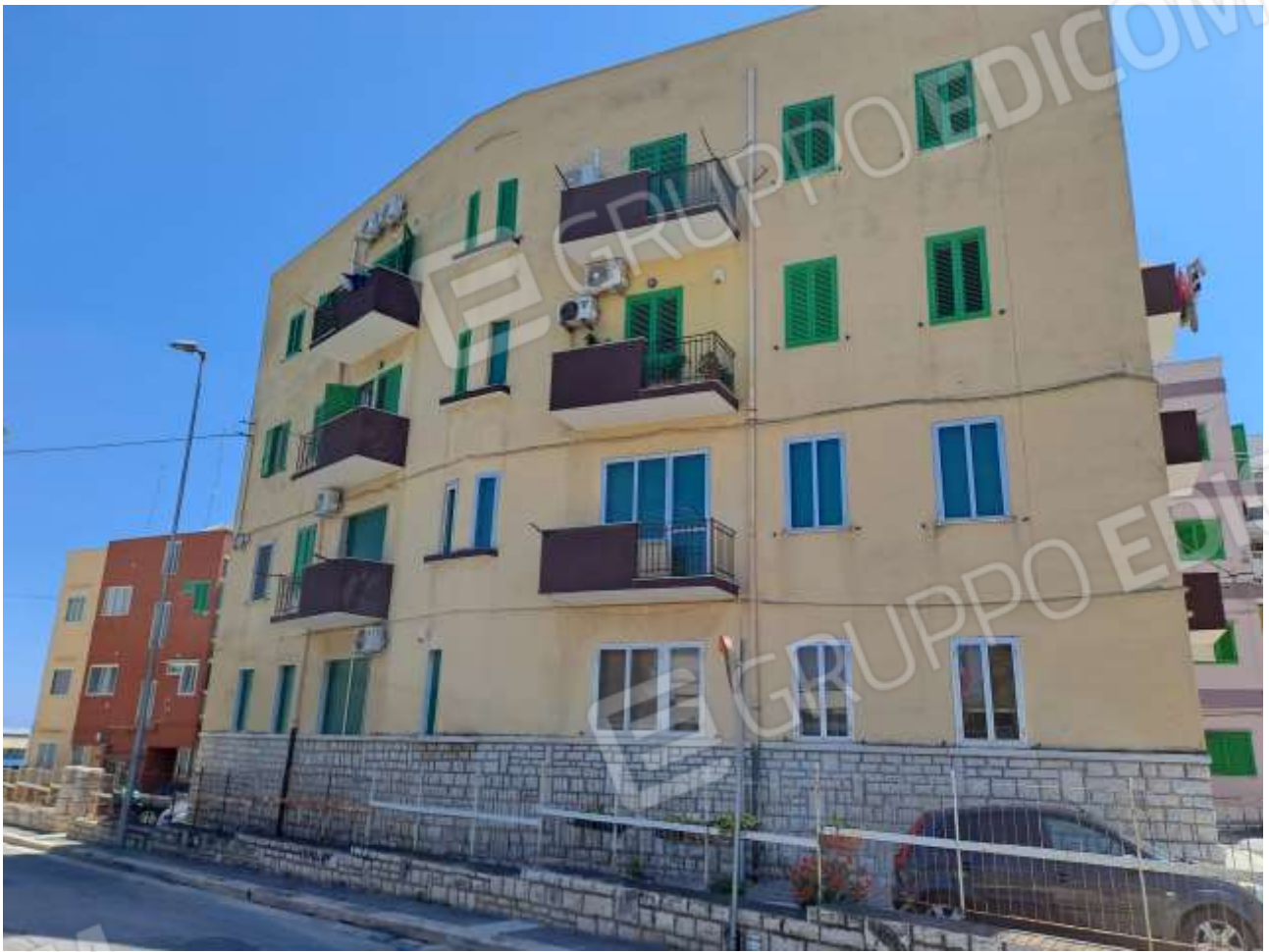
Figura 4 - vista dell'edificio del quale fa parte l'u.i. oggetto di perizia
