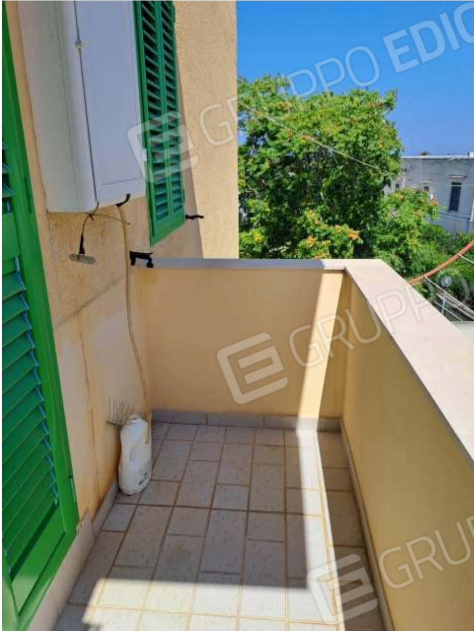
Figura 10 - vista del balcone con accesso dalla cucina/pranzo
