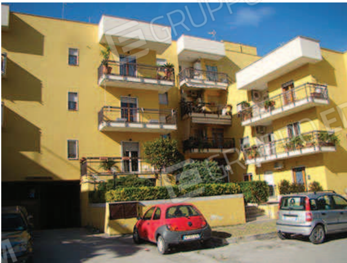
Foto n. 1 Vista ingresso edificio dal cortile su Via Corsica N. 168
