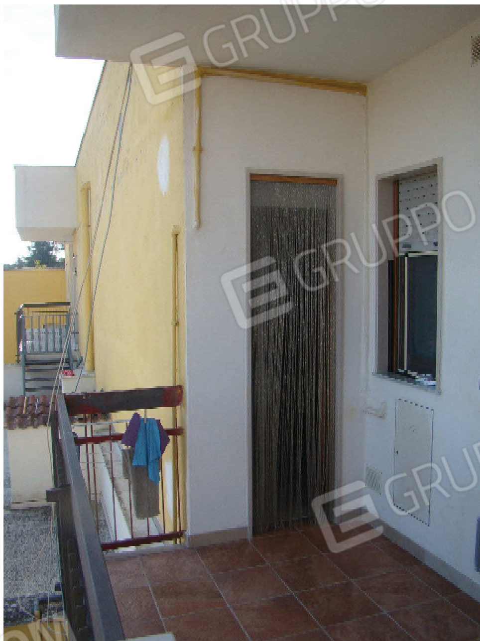
Foto n. 16 Vista Balcone Su Cortile Via Corsica
