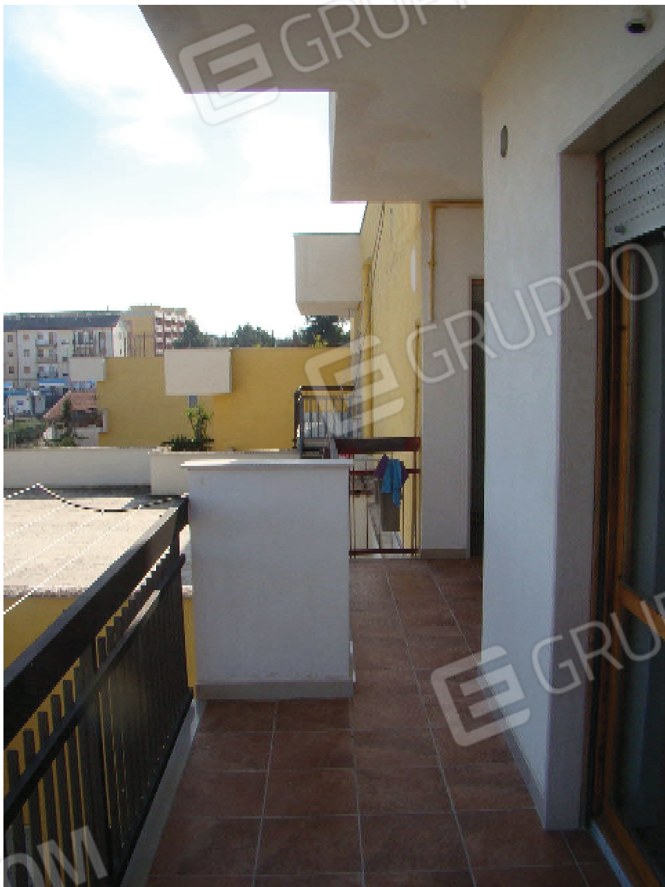
Foto n. 17 Vista Balcone Su Cortile Via Corsica
