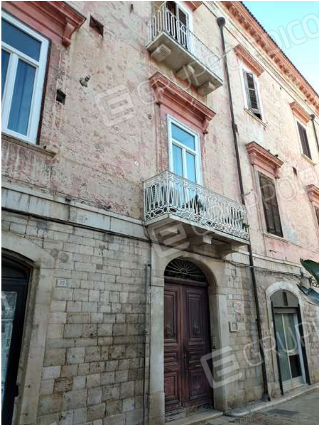
Foto n. 1: Prospetto esterno dell'immobile da piazza Tomaselli
