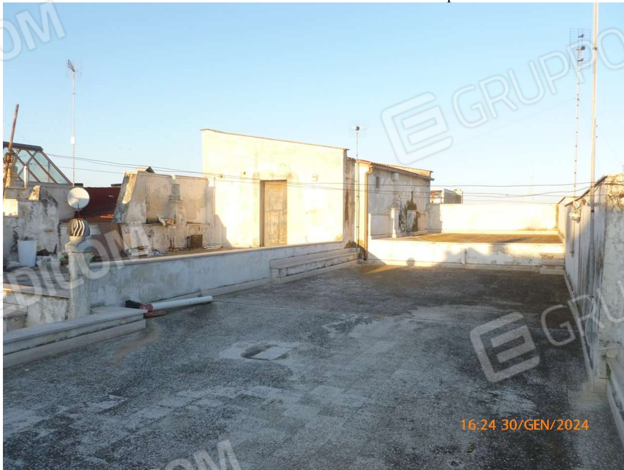
Foto 19: il lastrico solare condominiale al terzo piano
