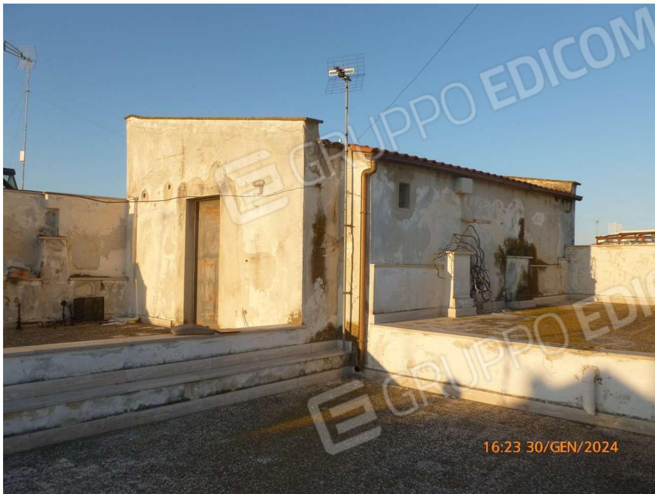
Foto 18: il lastrico solare condominiale al terzo piano
