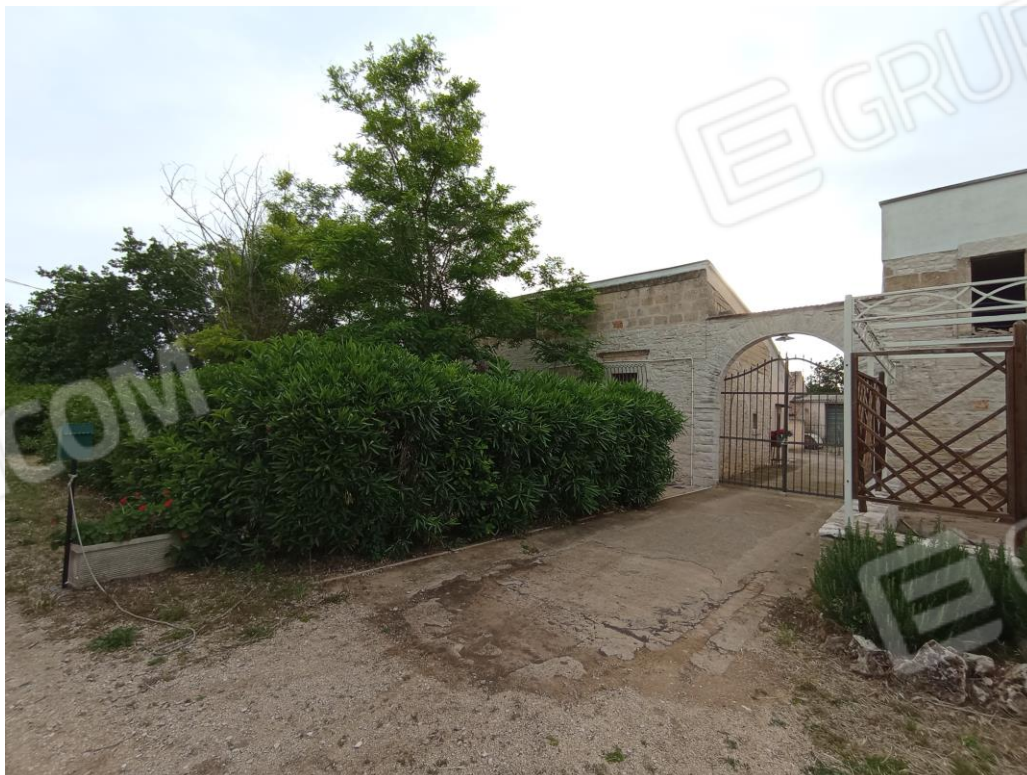
FOTO N. 5 - PASSAGGIO ALTRA PROPRIETA'
