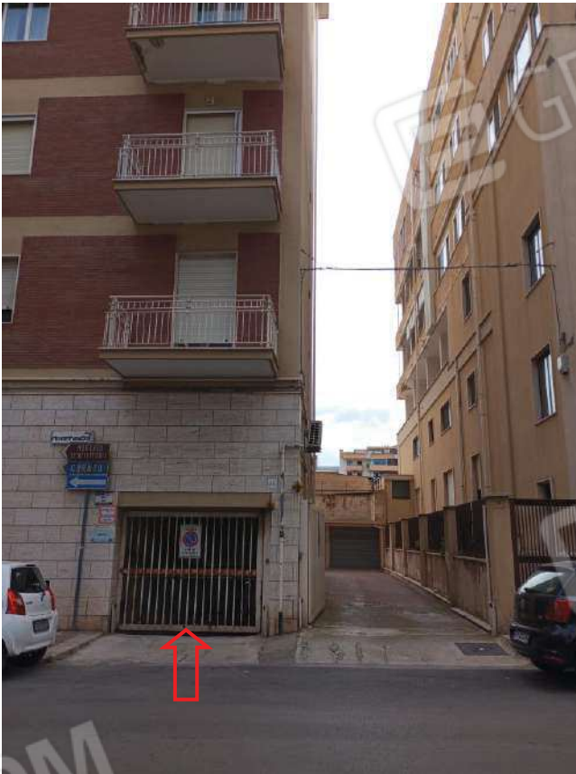
Foto n. 6: vista accesso su via Monte Pasubio 20
