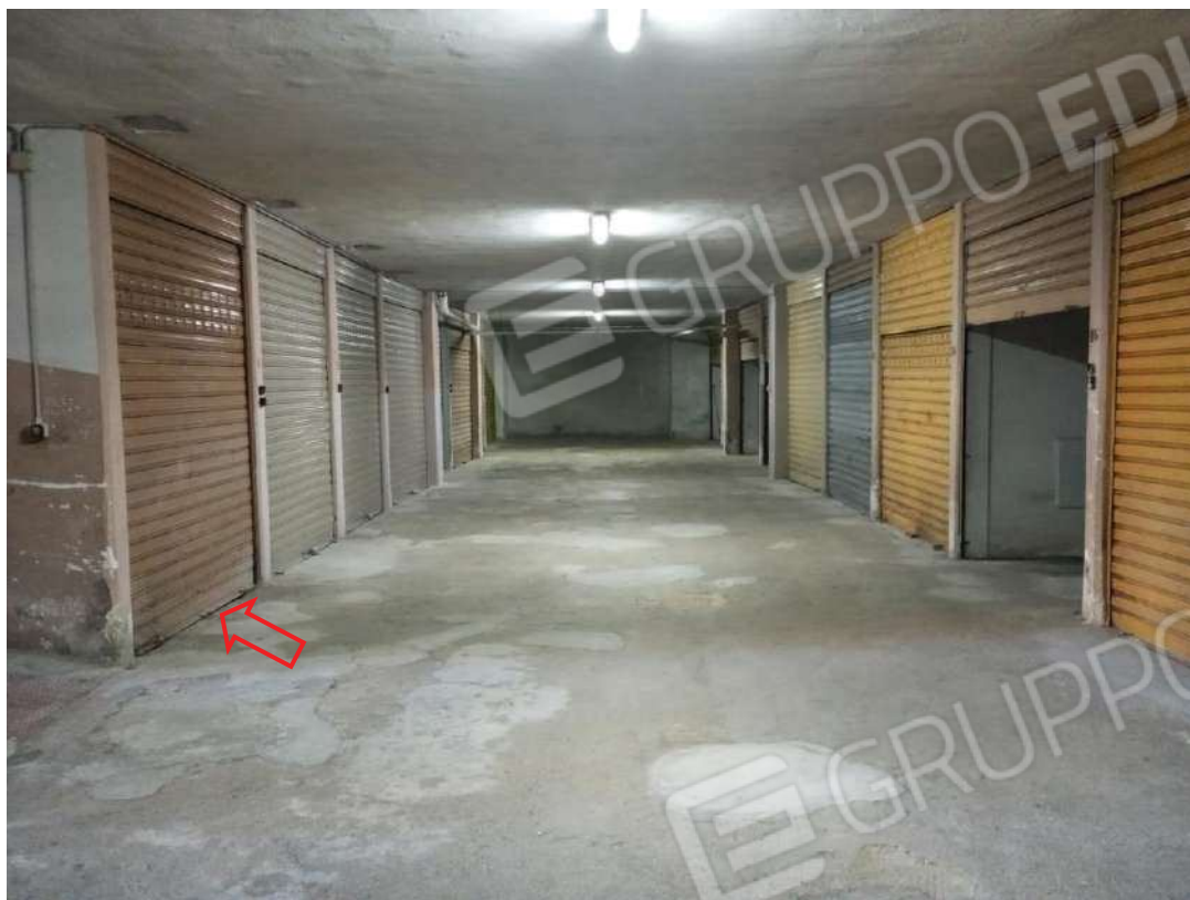
Foto n. 8: corsia condominiale – indicazione locale oggetto di pignoramento
