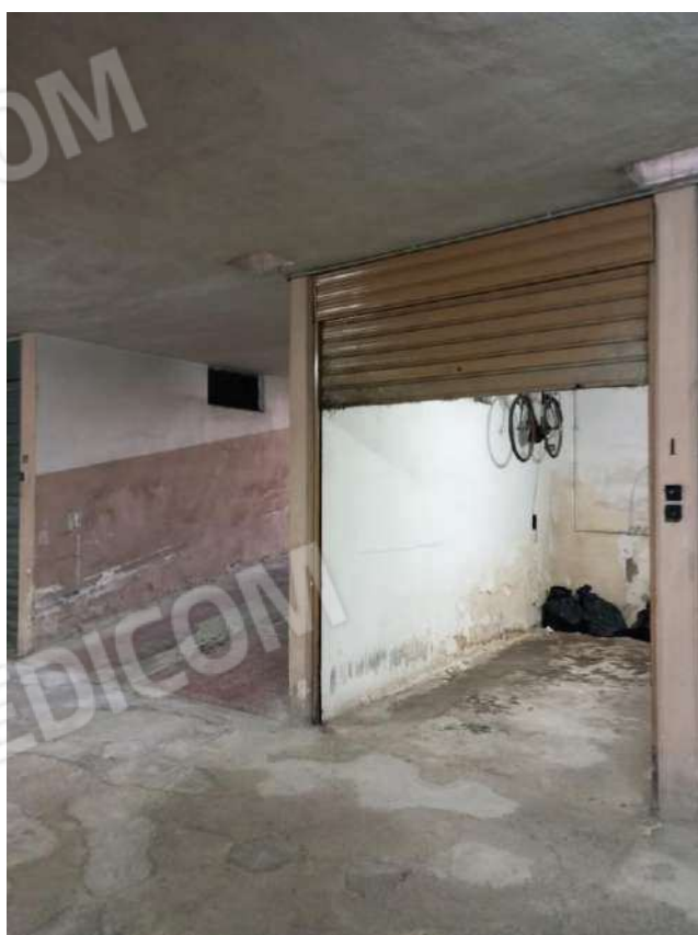
Foto n. 9: immobile – vista da corsia
