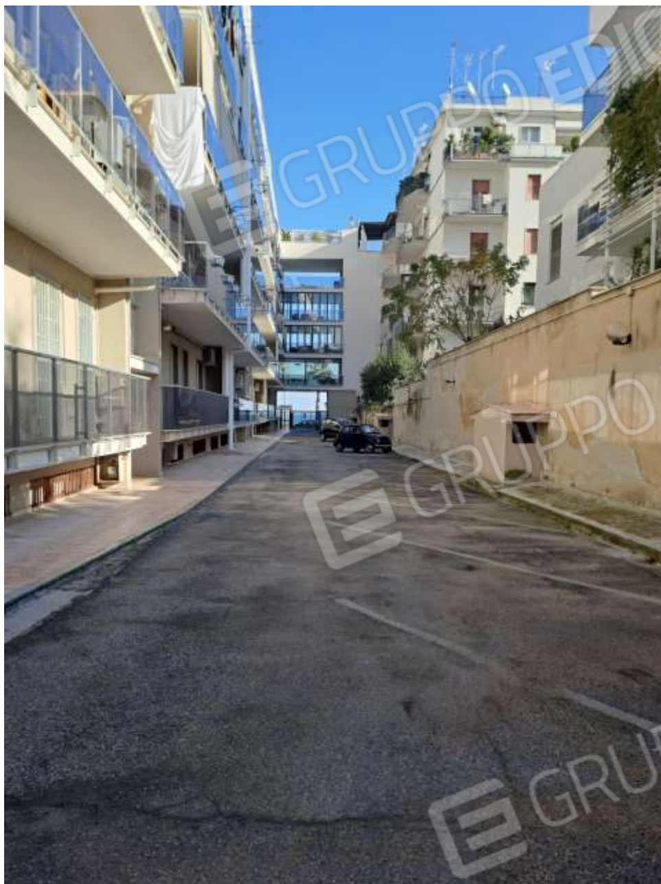
Figura 27 - area a cielo aperto condominiale carrabile con accesso dal lungomare C. Colombo n.10
