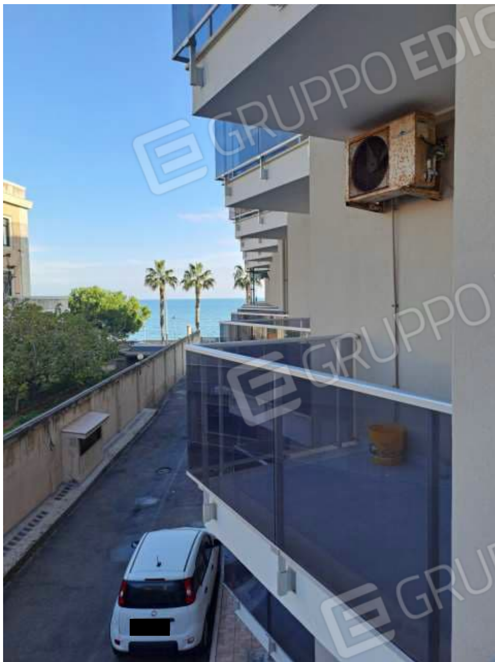
Figura 26 - balcone camera letto matrimoniale (prospetto lato nord-ovest)
