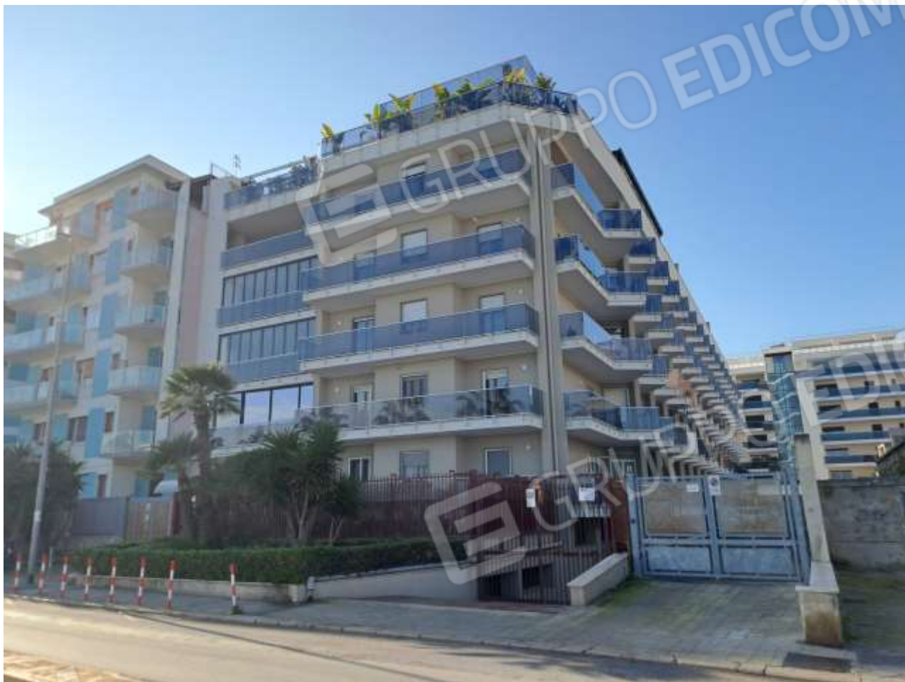
Figura 3 - vista dell'intero edificio e del prospetto laterale (lato nord-ovest)
