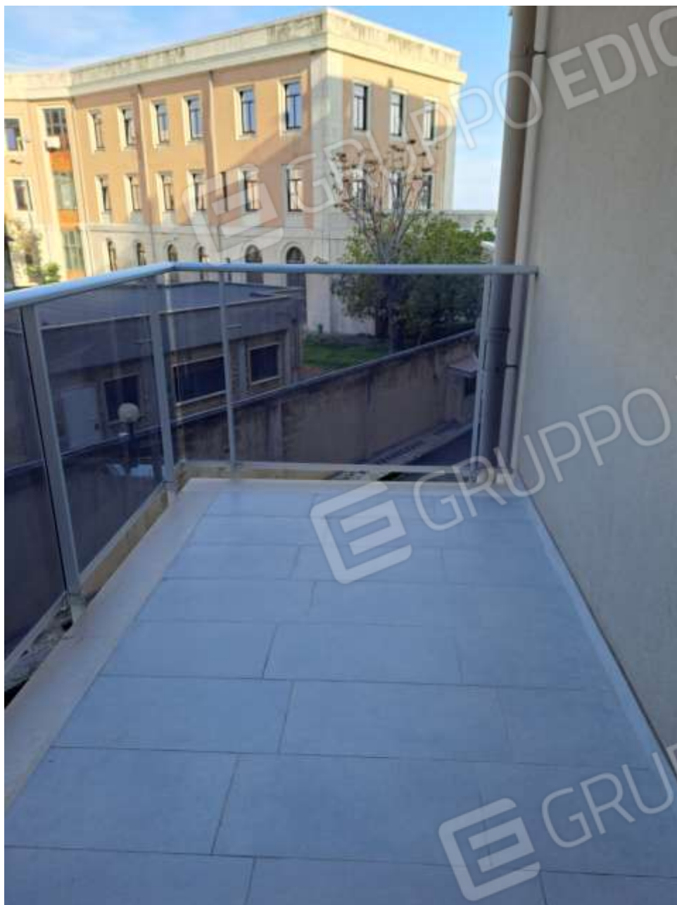
Figura 25 - balcone soggiorno (prospetto lato nord-ovest)
