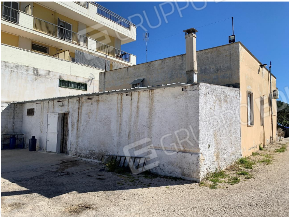
Foto 5. Vista fabbricato lato Ovest
