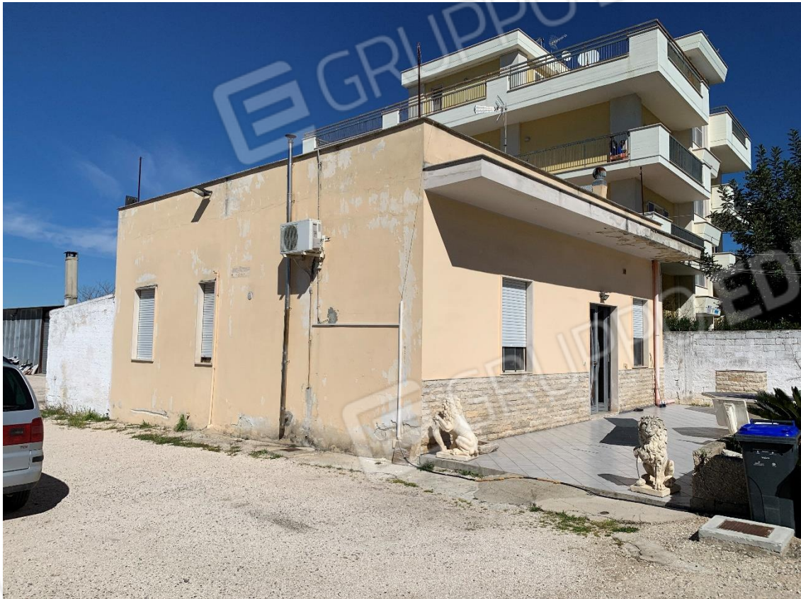
Foto 4. Vista fabbricato lato Sud - Est
